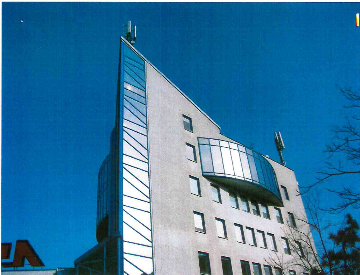
Zał. nr 1: Widok ogólny instalacji radiokomunikacyjnej.
