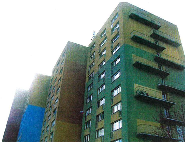
Zał. nr 1: Widok ogólny instalacji radiokomunikacyjnej.
