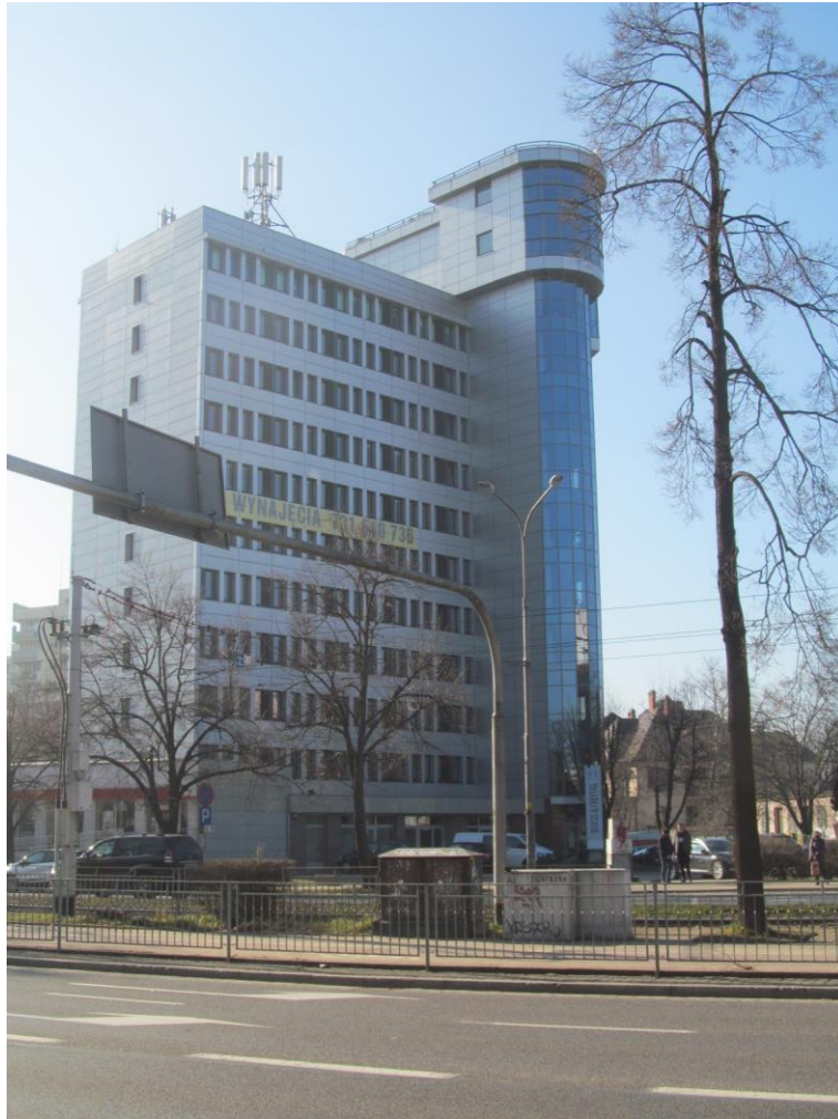
Zał. nr 1: Widok ogólny instalacji radiokomunikacyjnej.
