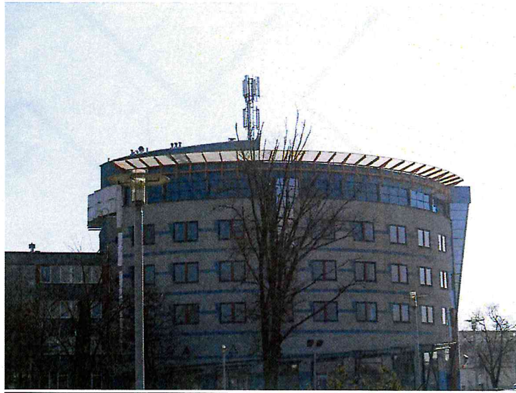
Zał. nr 1: Widok ogólny instalacji radiokomunikacyjnej.
