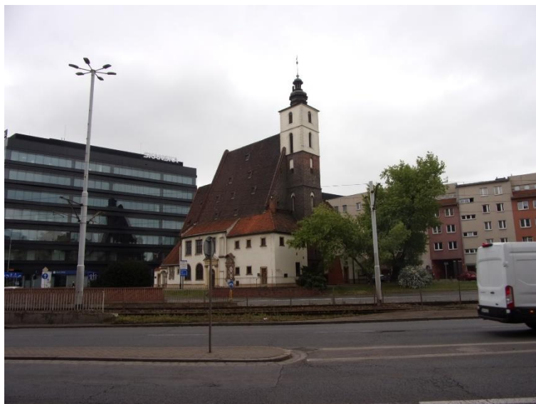
Zał. nr 1: Widok ogólny instalacji radiokomunikacyjnej.
