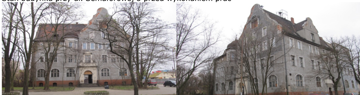
Stan budynku przy ul. Semaforowej 5 przed wykonaniem prac
