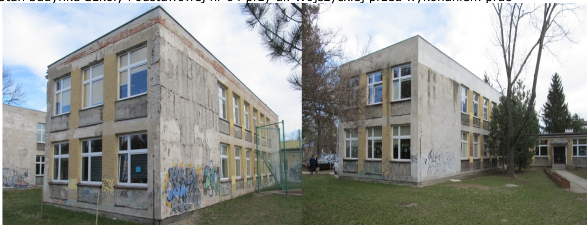
Stan budynku Szkoły Podstawowej nr 64 przy ul. Wojszyckiej przed wykonaniem prac
