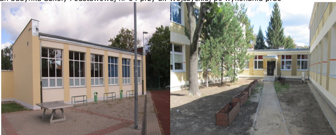
Stan budynku Szkoły Podstawowej nr 64 przy ul. Wojszyckiej po wykonaniu prac
