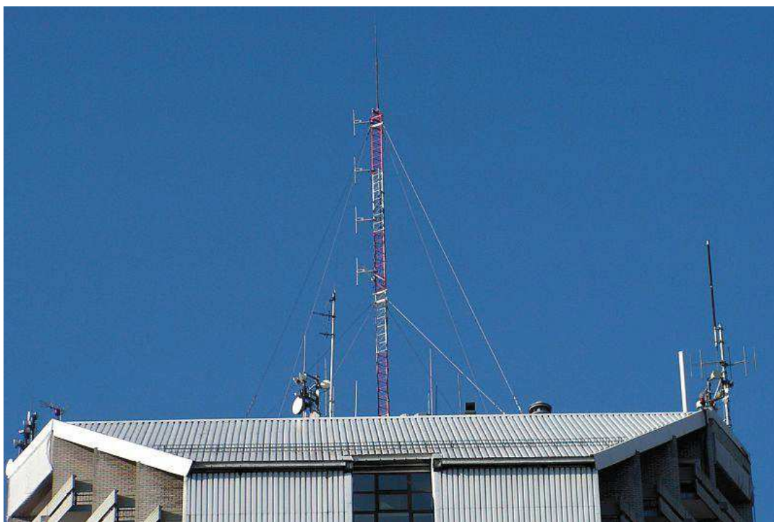
Fot. 1. Radiowa Stacja Nadawcza DS. Kredka – widok anten na dachu budynku
