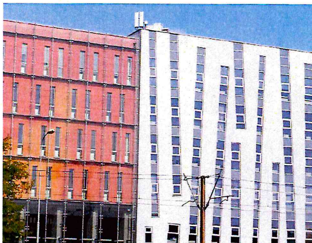
Zał. nr 1: Widok ogólny instalacji radiokomunikacyjnej.
