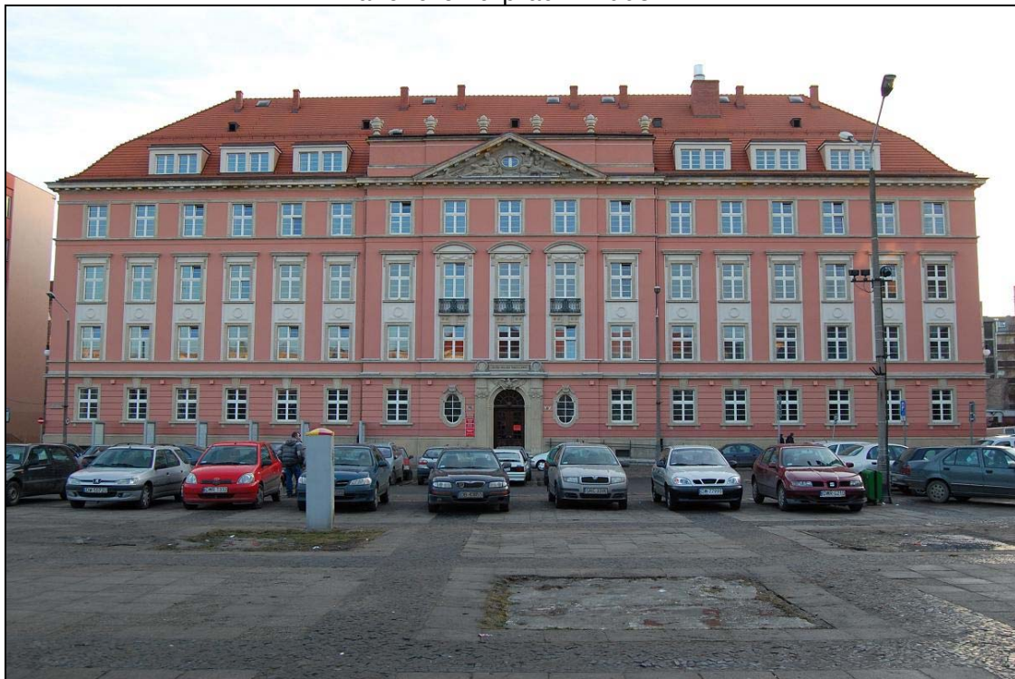
Widok elewacji budynku Urzędu Miejskiego Wrocławia przy pl. Nowy Targ 1/8 po zakończeniu prac w 2008 r.
