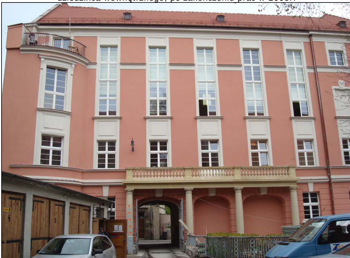
Widok elewacji budynku Urzędu Miejskiego Wrocławia przy pl. Nowy Targ 1/8 od strony dziedzińca wewnętrznego, po zakończeniu prac w 2008r.
