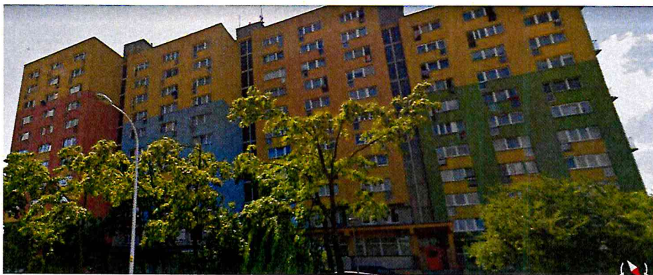
Zał. nr 1: Widok ogólny instalacji radiokomunikacyjnej.
