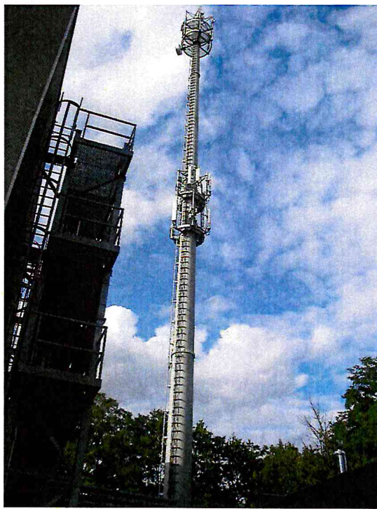
Zał. nr 1: Widok ogólny instalacji radiokomunikacyjnej.
