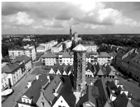
9. Średniowieczna wieża hali handlowej w Lubaniu. Fot. R. Eysymontt.
