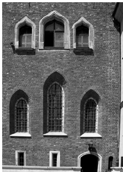
1. Fragment wrocławskiego Ratusza od strony wschodniej zawierający pomieszczenia urzędowe dla rajców (parter) i ławników (piętro), około 1330 r. Fot. D. Szatkowska, ze zbiorów Muzeum Miejskiego we Wrocławiu.
