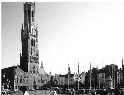
8. Beffroi na halach handlowych w Brugii. Fot. R. Eysymontt.
