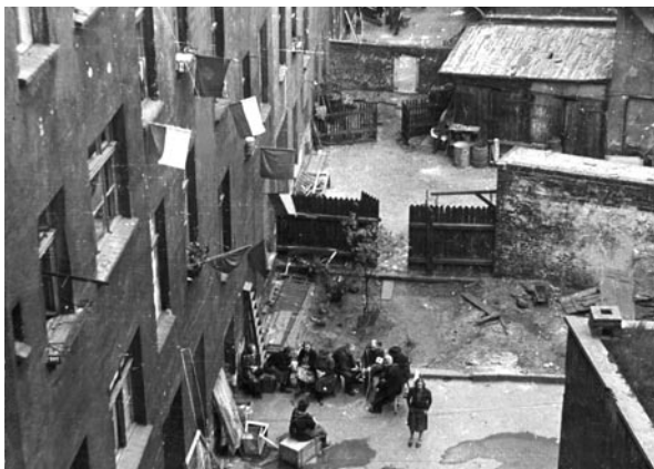
Podwórka kamienic przy ul. Poniatowskiego. (fot. Henryk Makarewicz)
