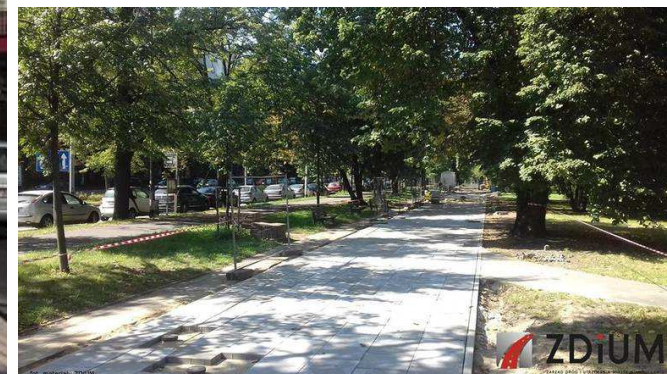
▲ Przebudowa chodnika w ul. Powstańców Śl. od SKY TOWER do pl. Powstańców Śl. (str.zach.)
