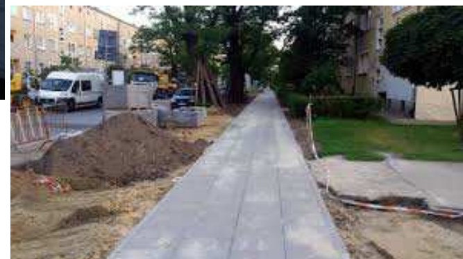
▲ Przebudowa chodnika w ul. Górniczej
