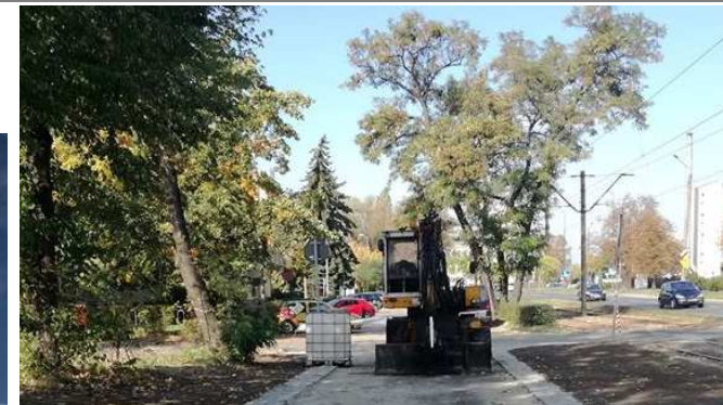
▲ Budowa brakującego chodnika w ul. Tarnogajskiej od parkingu przy Poczcie Polskiej do ul. Klimasa
