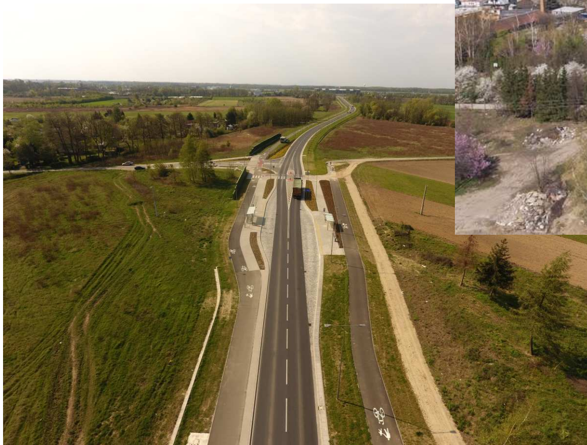
▲ Budowa Osi Zachodniej we Wrocławiu w ciągu drogi krajowej nr 94
