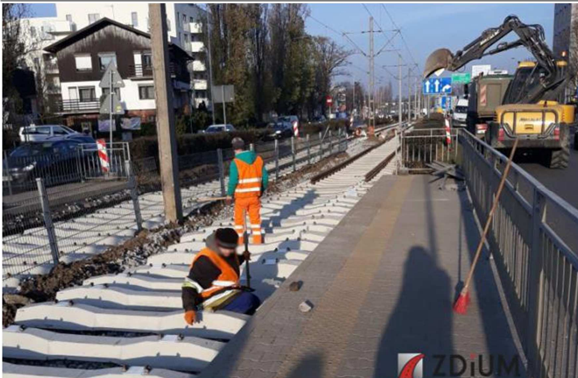
▲ Remont torowiska ul. Ślężna od ul. Wiśniowej do Weigla
