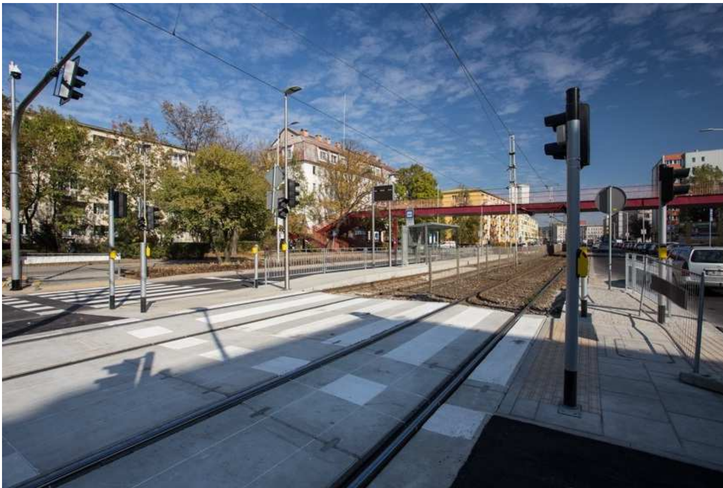
▲ Budowa przejścia dla pieszych i rowerów w rejonie skrzyżowania ul. Grabiszyńskiej z ul. Kolejową
