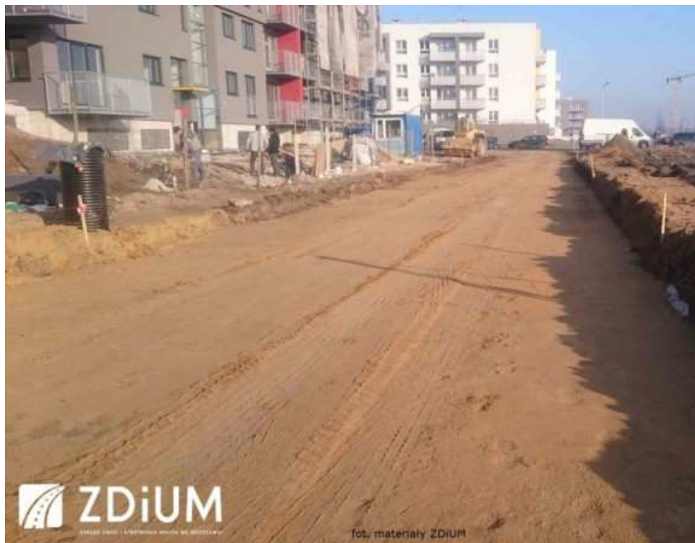
▲ Budowa ul. Szalwiowej (S.M. Osada)
