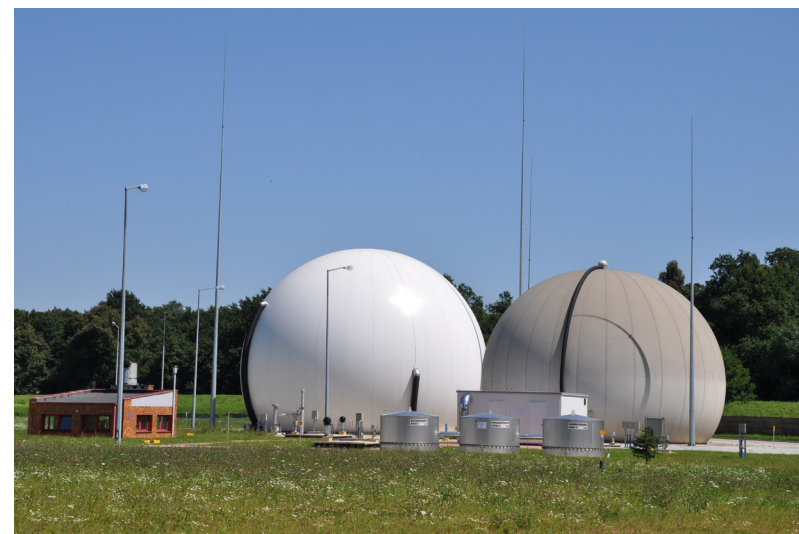
Zbiorniki biogazu Wrocławskiej Oczyszczalni Ścieków.
