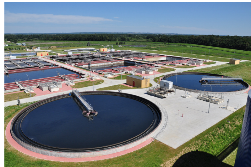
Dwa nowe osadniki wstępne Wrocławskiej Oczyszczalni Ścieków.
