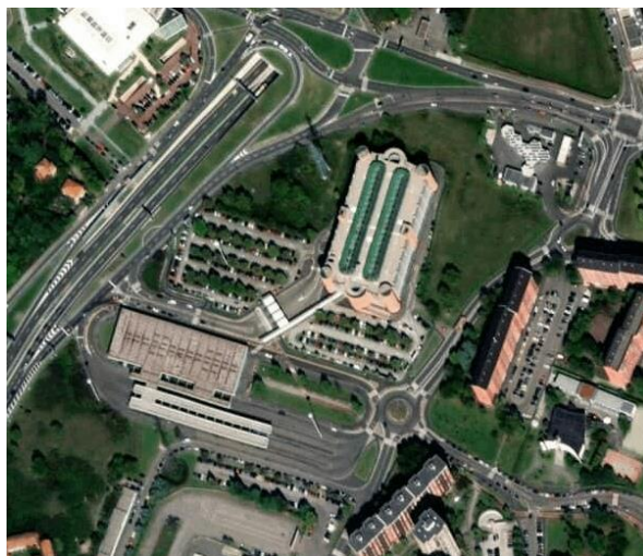
Rys. 6.14 Parking „parkuj i jeźdź” usytuowany w pobliżu autostrady, połączony ze stacją metra i dworcem autobusowym.
