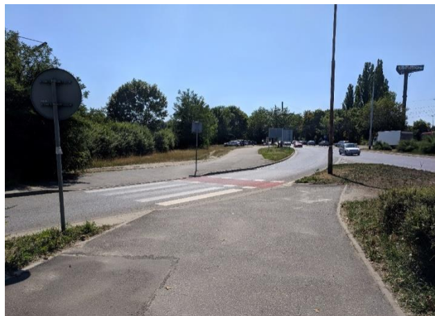
Rys. 4.41 Koniec ciągu pieszo-rowerowego na ul. Krakowskiej. Za przejazdem brakuje ścieżki rowerowej w stronę Księży i Radwanic.
