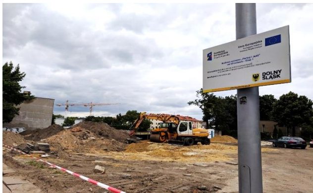
Rys. 4.60 Budowa parkingu P+R przy ul. Opolskiej.
