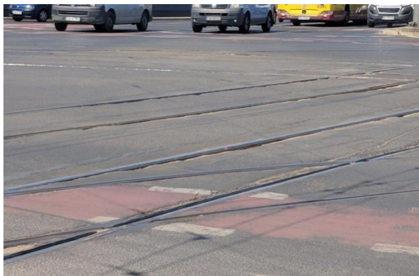
Rys. 4.55 Zły stan techniczny torowiska na pl. Jana Pawła II.
