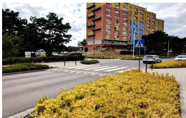
Rys. 4.68 Wyniesione przejście dla pieszych na ul. ks. M. Stanety.
