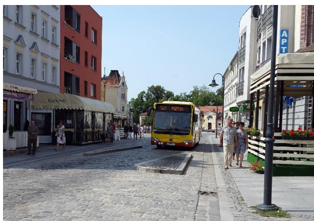
Rys. 4.19 Zawężenie jezdni przed Rynkiem Psiego Pola wzmacniające przekaz o wjeździe do strefy ruchu uspokojonego.
