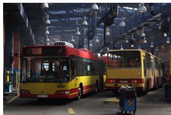
Rys. 5.20 Hala techniczna na zajezdni MPK Wrocław Sp. z o.o. (źródło: „Zajezdnia przy Obornickiej na nowo” www.wroclaw.pl [dostęp 06.11.2018])
