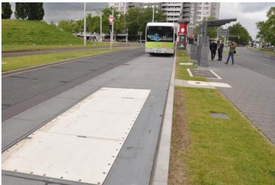
Rys. 6.7 Ładowarka indukcyjna wbudowana w jezdnię 60
