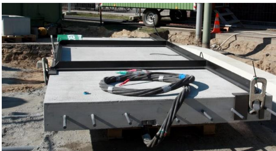
Rys. 6.8 Element ładowarki indukcyjnej wbudowanej w jezdnię 61
