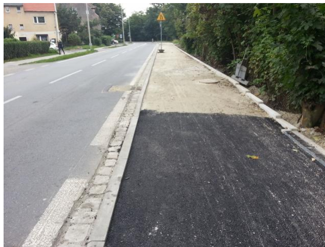
Budowa chodnika ul. Kowalska ( http://www.zim.wroc.pl/inwestycje/budowa_chodnika_w_ul_kowalskiej_we_wroclawiu_172.html&referer=inwestycje_w_realizacji )
