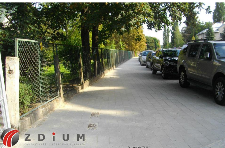
Przebudowa chodnika w ul. Bujwida pomiędzy ul. Sopotką a zjazdem do Archiwum Politechniki Wrocławskiej (Gdańska 7/9)
