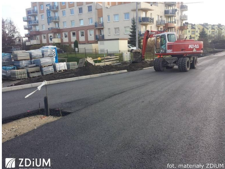
Budowa ul. Skarbowców na odcinku od Róży Wiatrów do Szarugi – inwestycja w realizacji do 2018 r.
