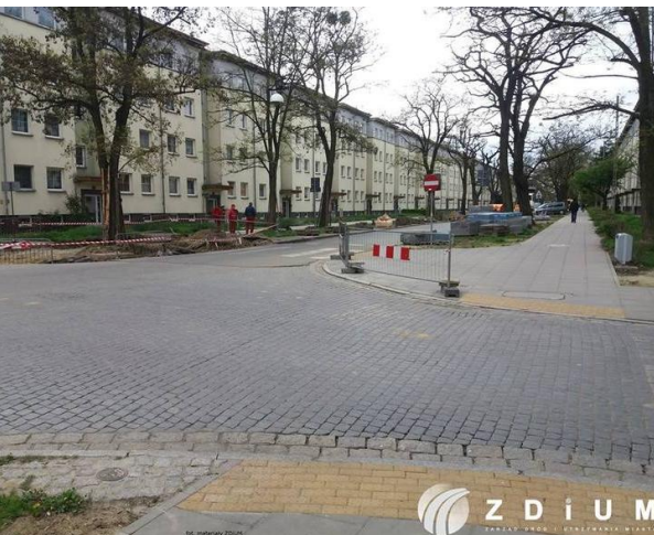
Przebudowa chodnika w ul. Górniczej
