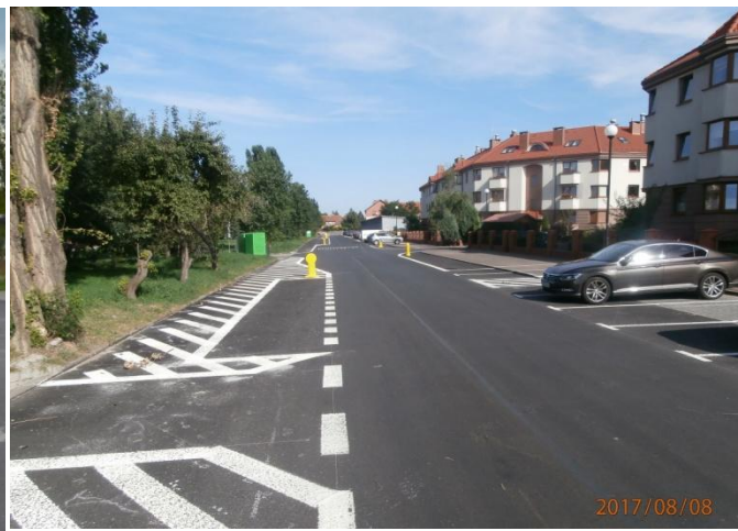
Budowa układu drogowego w ul. Maczka wraz z sygnalizacją Fot. ZDIUM
