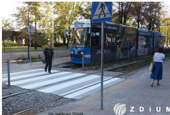
Przebudowa peronów przystankowych na ul. Powstańców Śl. przy ul. Wielkiej w celu wyznaczenia przejścia dla pieszych
