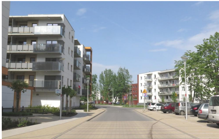
Przebudowa ul. Magellana (deweloper Archicom)
