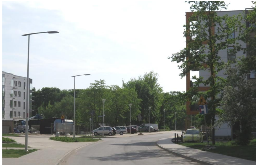
Przebudowa ul. Magellana (deweloper Archicom)
