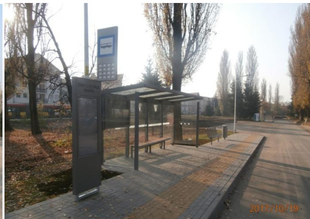
Pętla autobusowa przy ul. Zwycięskiej Fot. ZDIUM
