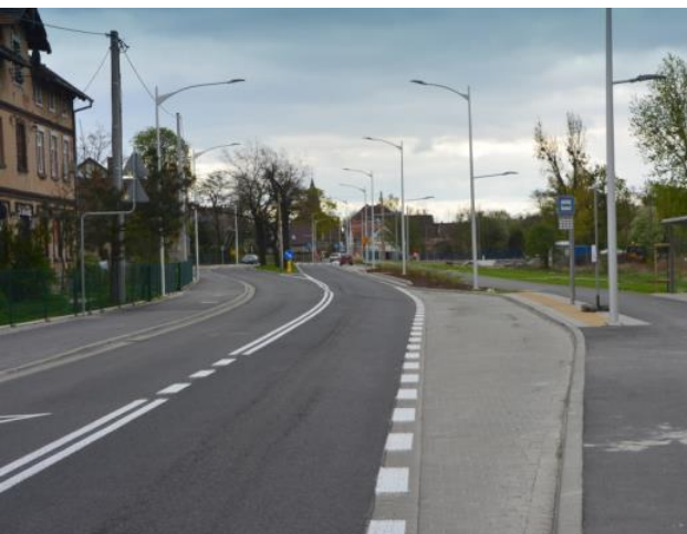
Przebudowa ul. Miłoszyckiej http://www.rynekinfrastruktury.pl/wiadomosci/drogi/wroclaw-otwarto-ul-miloszycka-i-most-strachocinski-58193.html
