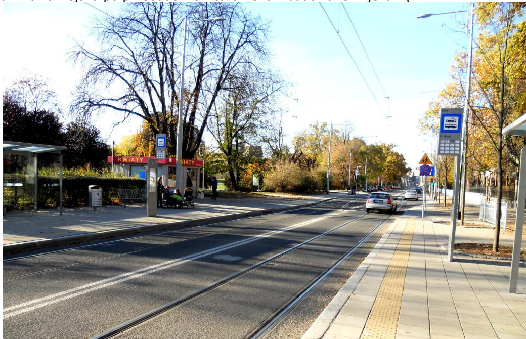
ul. Nowowiejska po przebudowie - torowisko wbudowane w jezdnię.
