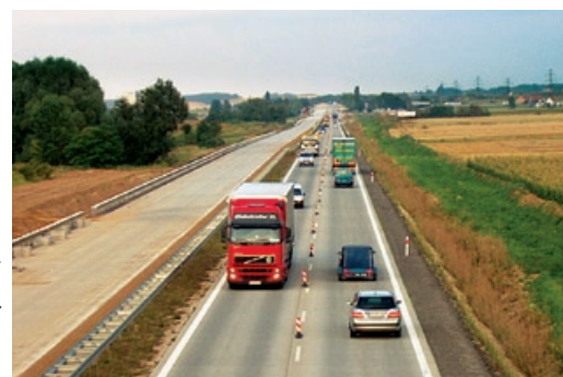
Rozbudowa autostrady A4 w rejonie Legnicy
