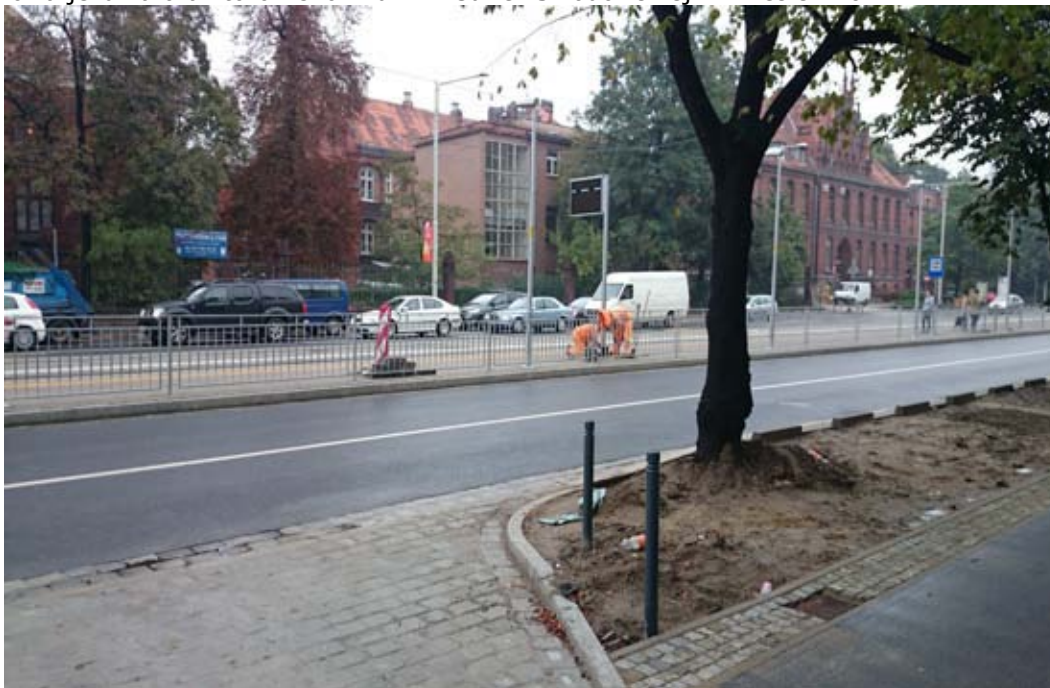
Nowa jezdnia oraz torowisko w ul. M. Curie- Skłodowskiej - wrzesień 2014 r.
