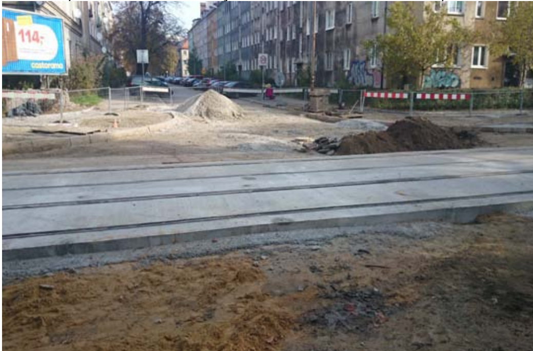
Roboty budowlane ul. Nowowiejska - torowisko wbudowane - listopad 2014 r.
