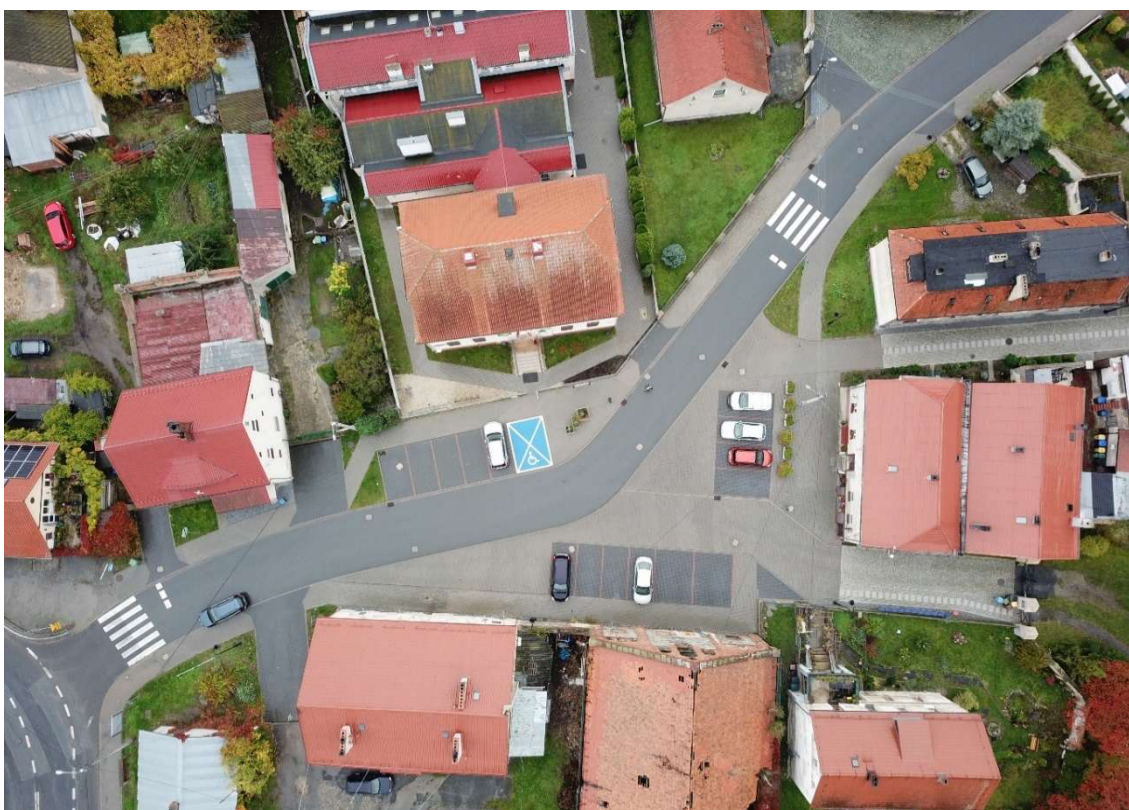
Rysunek 8. Gmina Borów – przebudowa ul. Szkolnej
