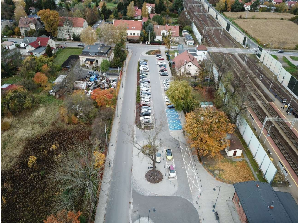
Rysunek 29. Gmina Siechnice – Park&Ride przy stacji kolejowej Św. Katarzyna
