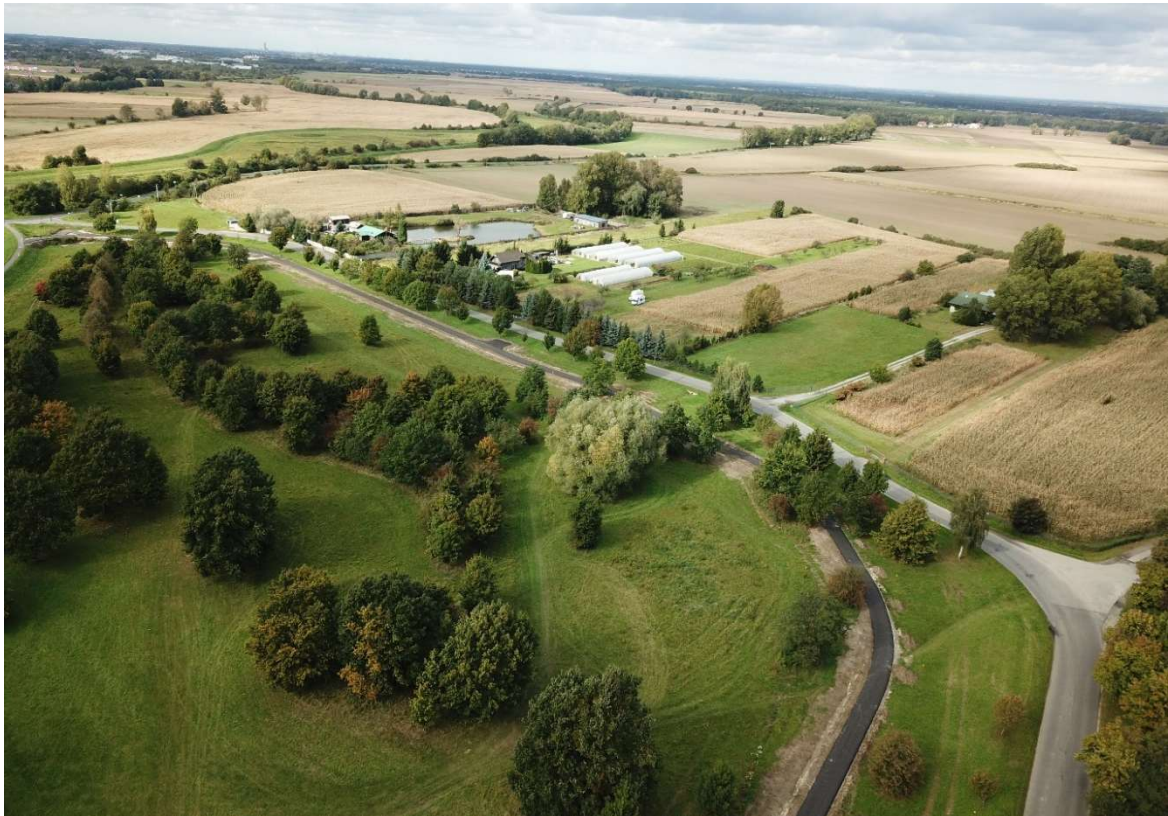
Rysunek 6. Gmina Miasto Oława – budowa drogi dla pieszych i rowerów wzdłuż ul. Rybackiej
