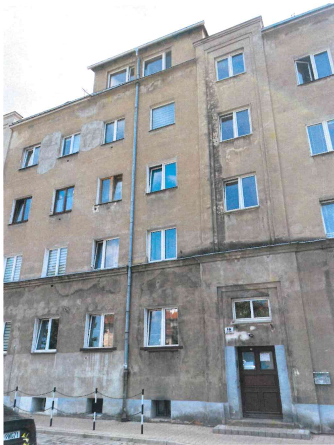
widok od podwórza, wejście do klatki schodowej – ul. Jaracza 10
