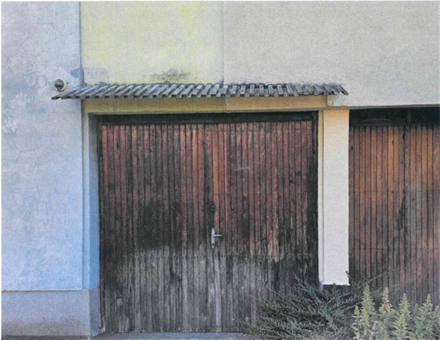
brama garażowa budynku przy ul. Czereśniowej 31
