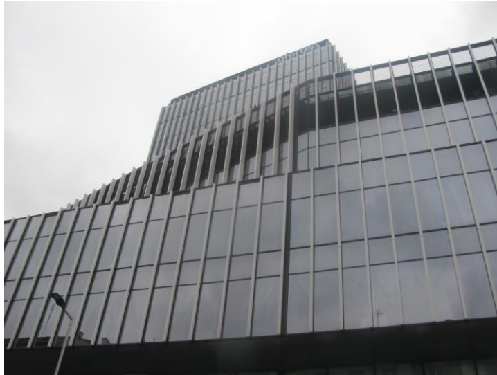
Zał. nr 1: Widok ogólny instalacji radiokomunikacyjnej.
