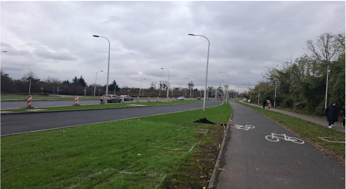
Fotografia 67. Zdjęcie przedstawiające wybudowaną jezdnię autobusową – widok w kierunku przejazdu kolejowego
