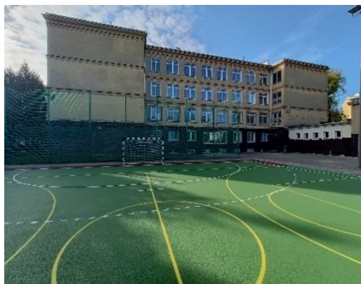
Fotografia 31. Nowe boisko przy ulicy Bolesława Prusa
