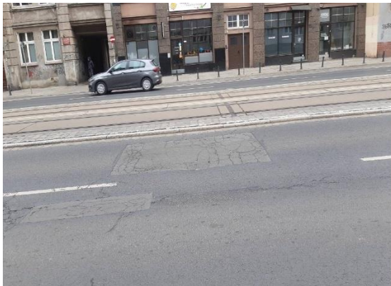
Fotografia 11. Ulica Piotra Skargi przed remontem
