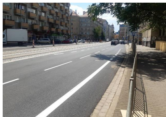
Fotografia 10. Ulica Hugona Kołłątaja po remoncie
