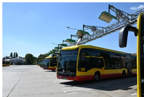
Fotografia 81. Infrastruktura ładowania autobusów elektrycznych
