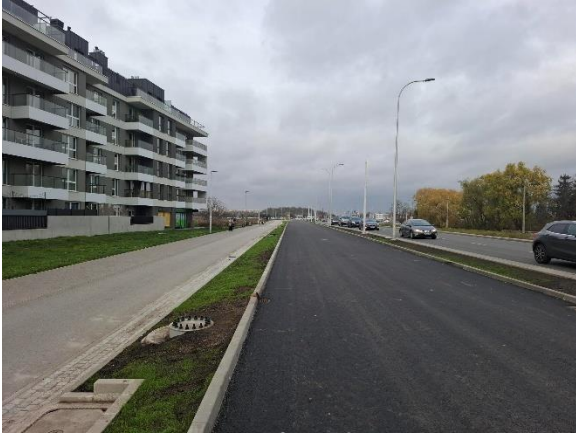
Fotografia 65. Zdjęcie przedstawiające wybudowaną jezdnię autobusową – widok w kierunku centrum
