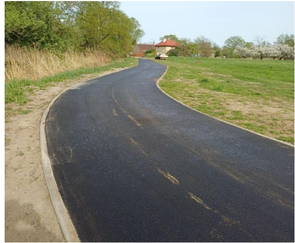
Fotografia 18. Łącznik ulicy Złotej Lilii po utwardzeniu nawierzchni
