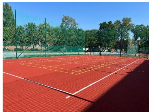
Fotografia 30. Nowe boisko przy ulicy Ścinawskiej
