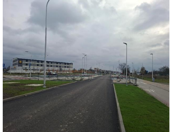
Fotografia 66. Zdjęcie przedstawiające wybudowaną jezdnię autobusową – widok w kierunku Jagodna
