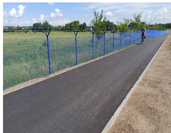
Fotografia 16. Ścieżka pieszo-rowerowa w ramach rozbudowy ulicy Żwirki i Wigury
