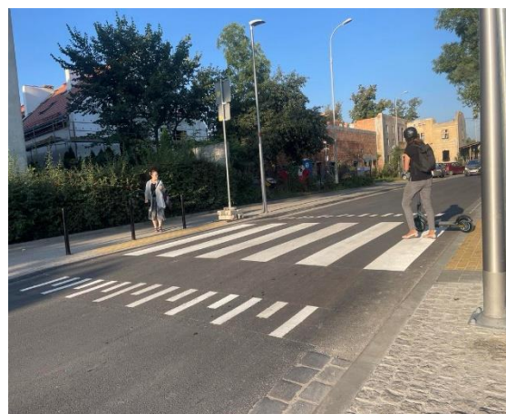
Fotografia 8. Ulica Asfaltowa po remoncie
