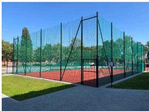
Fotografia 29. Nowe boisko przy ulicy Ścinawskiej
