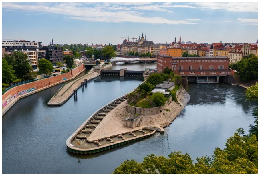
Rysunek 2-14 Elektrownia wodna Wrocław
