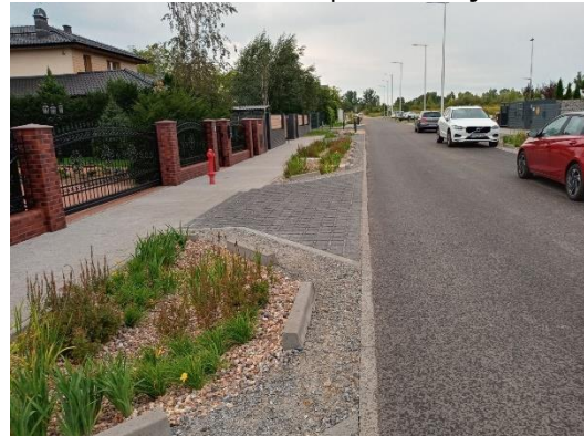
Fot. 8. ul. Marii Wittek - po realizacji inwestycji
