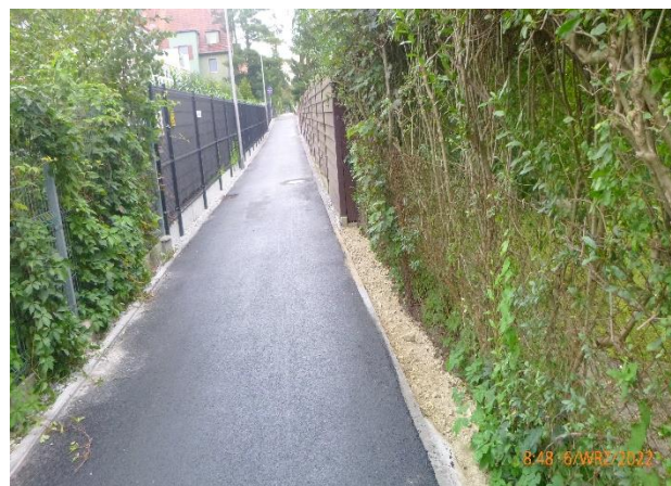
Fot. 6. ul. O. Boznańskiej po remoncie
