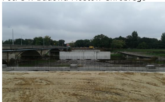
Fot. 54. Budowa Mostów Chrobrego
