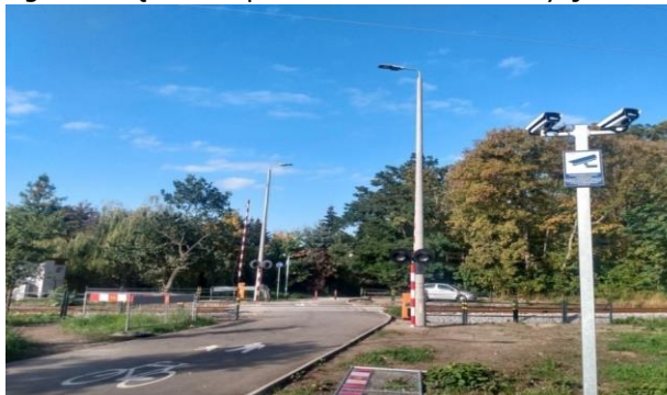
Fot. 57. Przejście pieszo-rowerowe przez linię kolejową nr 285, na skrzyżowaniu z ul. Agrestową – stan po zakończeniu inwestycji
