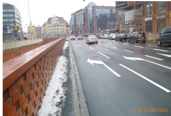
Fot. 60. ul. Oławska - po remoncie
