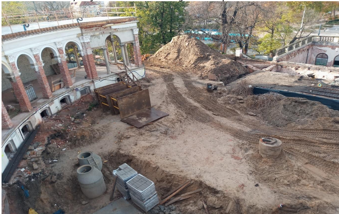
Fot. 39. Rewaloryzacja Bastionu Sakwowego – roboty budowlane
