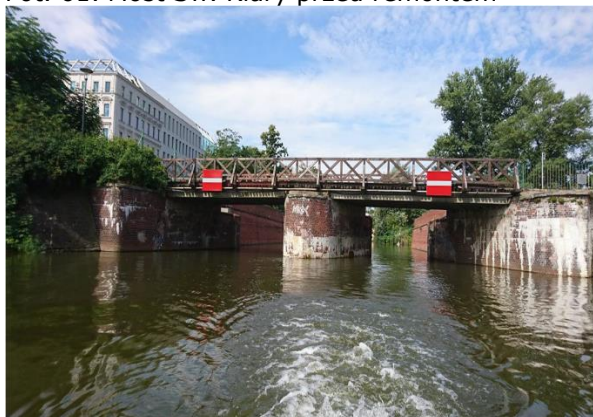
Fot. 61. Most Św. Klary przed remontem
