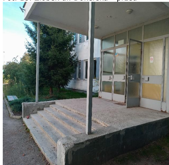
Fot. 18. Żłobek ul. Dokerska - przed
