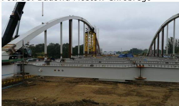
Fot. 53. Budowa Mostów Chrobrego
