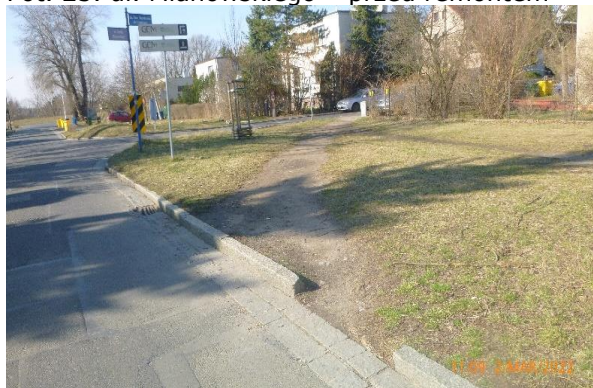
Fot. 25. ul. Mianowskiego – przed remontem
