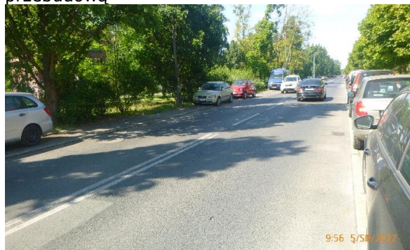
Fot. 9. ul. E. Dembowskiego przed przebudową
