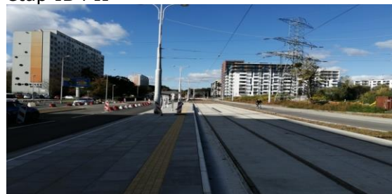
Fot. 51. Trasa tramwajowa wzdłuż ul. Popowickiej-Starogroblowej-Długiej - etap IB i II
