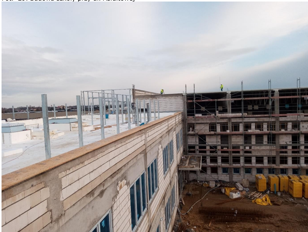
Fot. 29. Budowa szkoły przy ul. Asfaltowej
