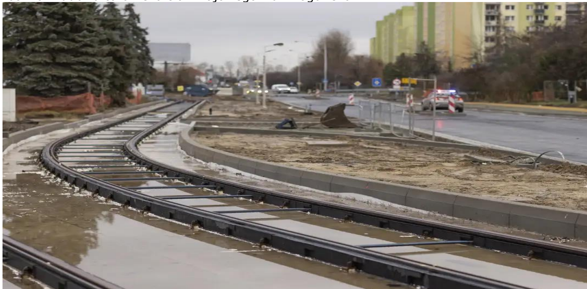
Fot. 48. Budowa torowiska tramwajowego - ul. Rogowska
