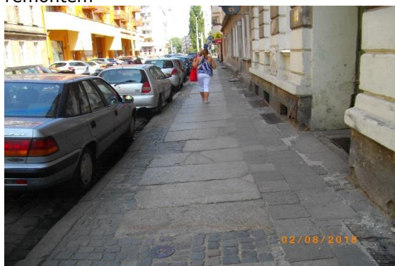
Fot. 27. ul. Sępa-Szarzyńskiego - przed remontem
