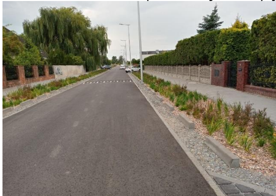
Fot. 7. ul. Marii Wittek - po realizacji inwestycji
