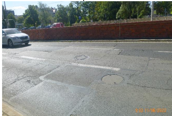
Fot. 59. ul. Oławska - przed remontem
