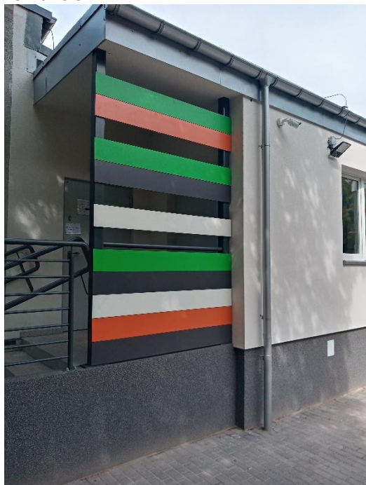
Fot. 30. Przedszkole przy ul. Zaporoskiej - po remoncie
