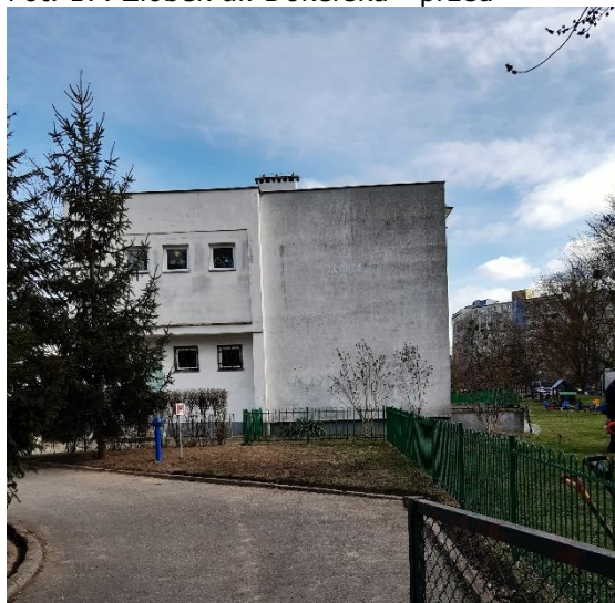
Fot. 17. Żłobek ul. Dokerska - przed
