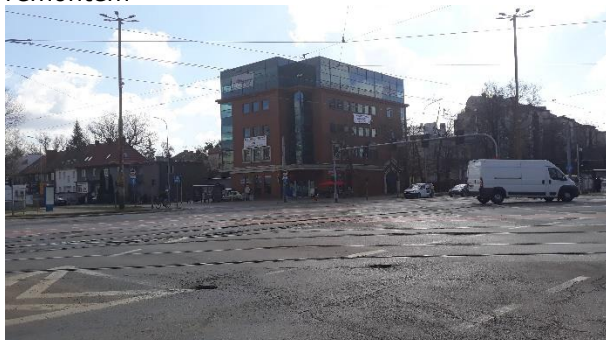
Fot. 3. Powstańców Śl./Hallera - przed remontem
