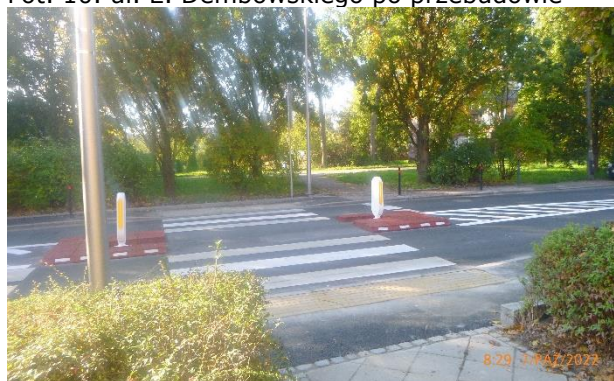
Fot. 10. ul. E. Dembowskiego po przebudowie
