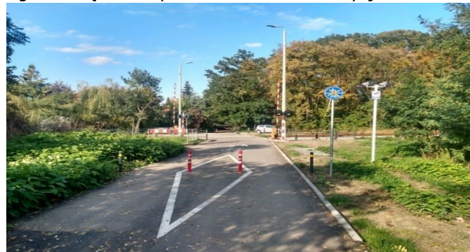
Fot. 58. Przejście pieszo-rowerowe przez linię kolejową nr 285, na skrzyżowaniu z ul. Agrestową – stan po zakończeniu inwestycji
