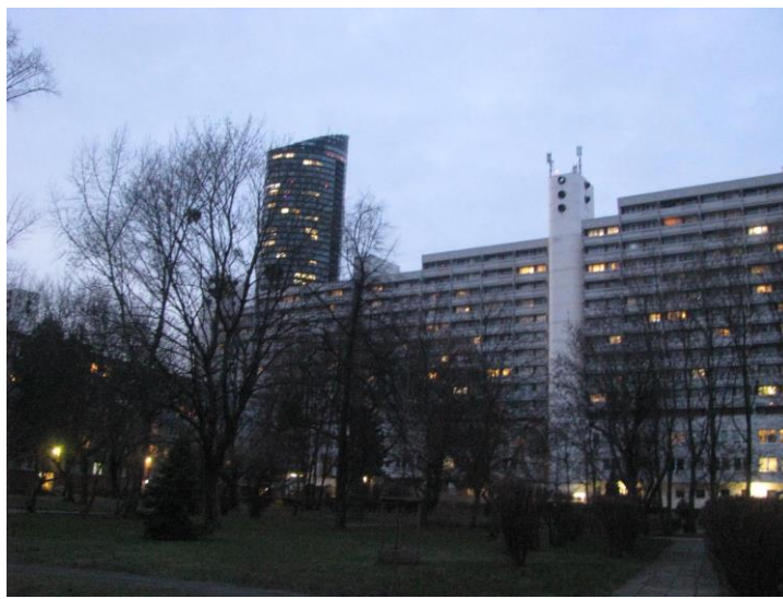
Zał. nr 1: Widok ogólny instalacji radiokomunikacyjnej.
