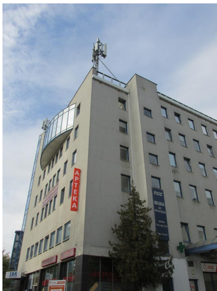
Zał. nr 1: Widok ogólny instalacji radiokomunikacyjnej.
