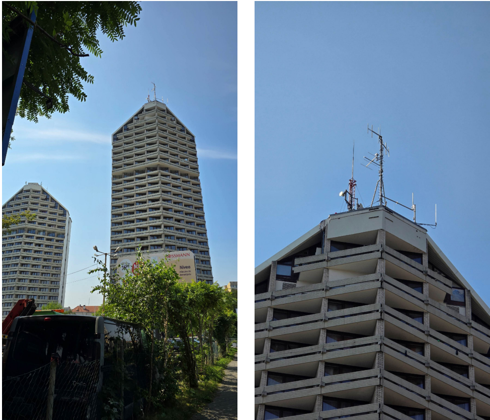
Widok obiektu wraz z zainstalowanym zespołem antenowym
