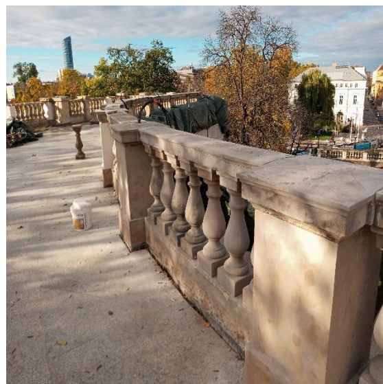
Fotografia 14. Bastion Sakwowy w trakcie przebudowy
