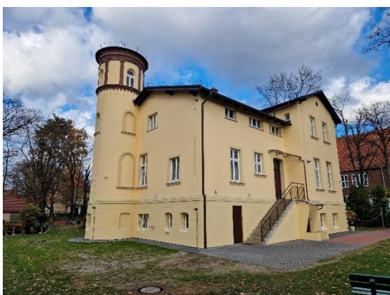
Fotografia 42. Elewacja Przedszkola numer 2 po remoncie
