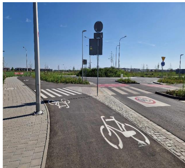
Fotografia 27. Ulica Asfaltowa po realizacji inwestycji
