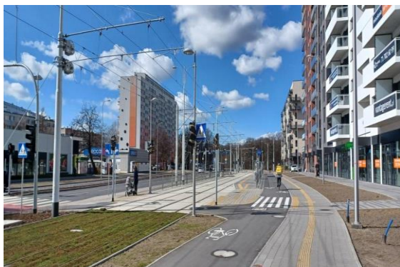
Fotografia 60. Trasa tramwajowa wzdłuż ulic Popowickiej - Starogrobłowej - Długiej - etap IB i II
