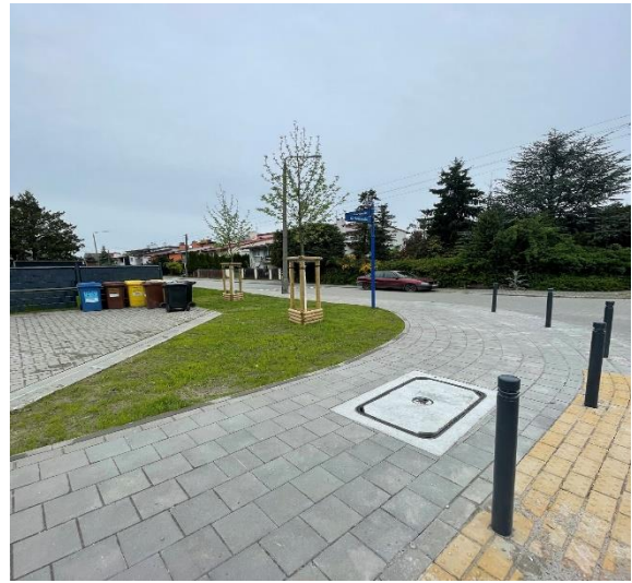
Fotografia 2. Ulica Stoszowska po realizacji inwestycji
