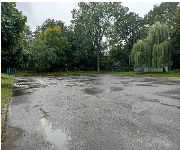
Fotografia 36. Ulica Sołtysowicka przed realizacją inwestycji
