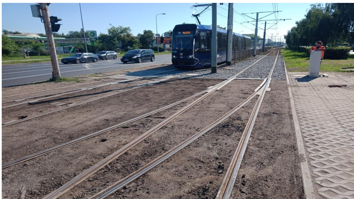
Fotografia 75. Wymiana rozjazdu z modernizacją nawierzchni ulic Milenijnej i Lotniczej
