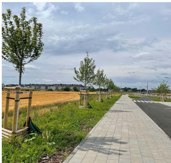
Fotografia 26. Ulica Asfaltowa po realizacji inwestycji
