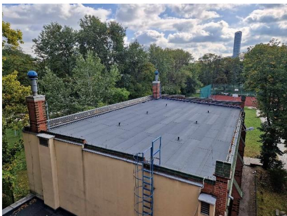
Fotografia 40. Dach Liceum Ogólnokształcącego numer XVII po realizacji inwestycji
