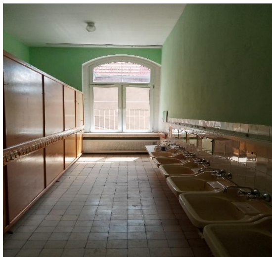
Fotografia 28. Toalety w Przedszkolu numer 50 przed realizacją inwestycji
