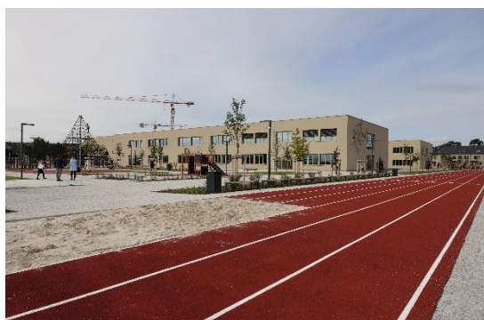
Fotografia 24. Nowa szkoła przy ulicy Asfaltowej
