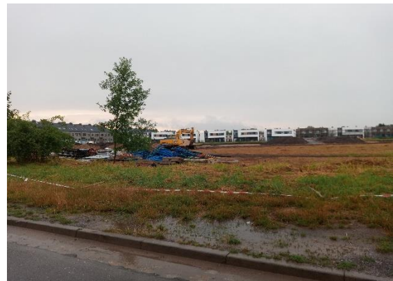
Fotografia 22. Teren budowy szkoły przy ulicy Asfaltowej
