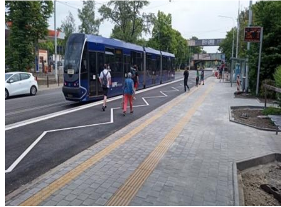
Fotografia 10. Przystanek wiedeński przy ulicy Grabiszyńskiej po realizacji inwestycji
