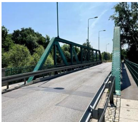
Fotografia 7. Nawierzchnia Mostu Marszowickiego przed realizacją inwestycji
