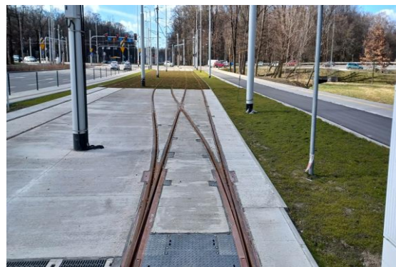
Fotografia 61. Trasa tramwajowa wzdłuż ulic Popowickiej - Starogrobłowej - Długiej - etap IB i II
