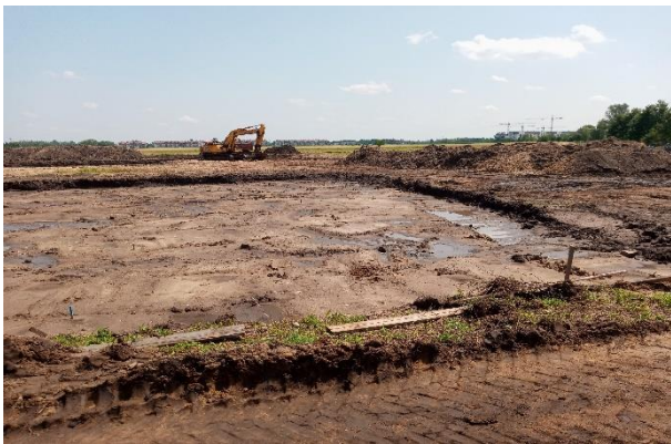
Fotografia 21. Teren budowy szkoły przy ulicy Asfaltowej
