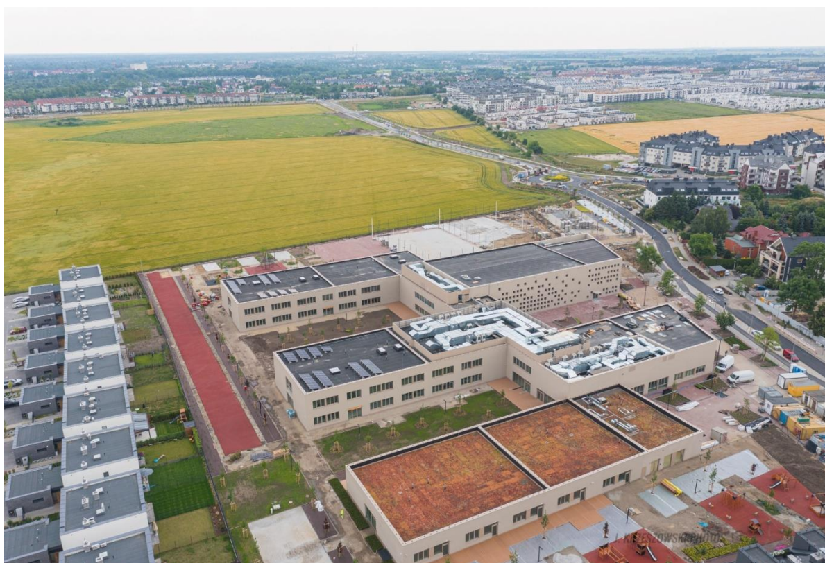
Fotografia 23. Nowa szkoła przy ulicy Asfaltowej
