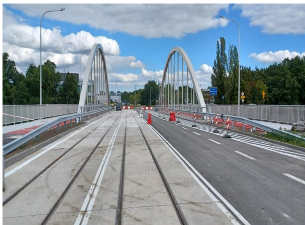
Fotografia 62. Budowa Mostów Chrobrego
