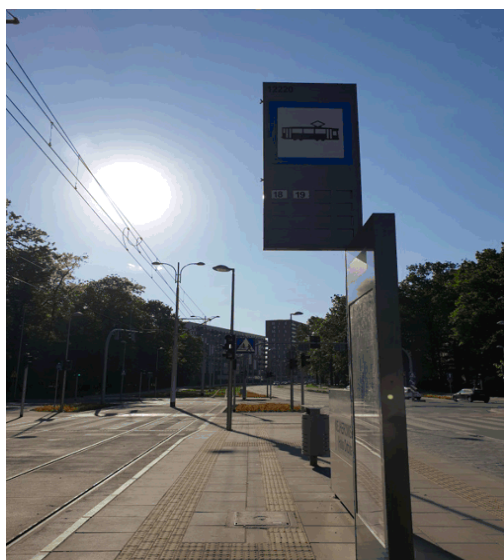
Fotografia 52. Przystanek na trasie linii tramwajowej w ciągu ulicy Długiej, Starogroblowej i Popowickiej
