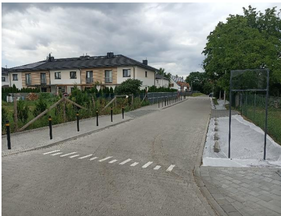
Fotografia 5. Ulica Dobrzykowicka po realizacji inwestycji
