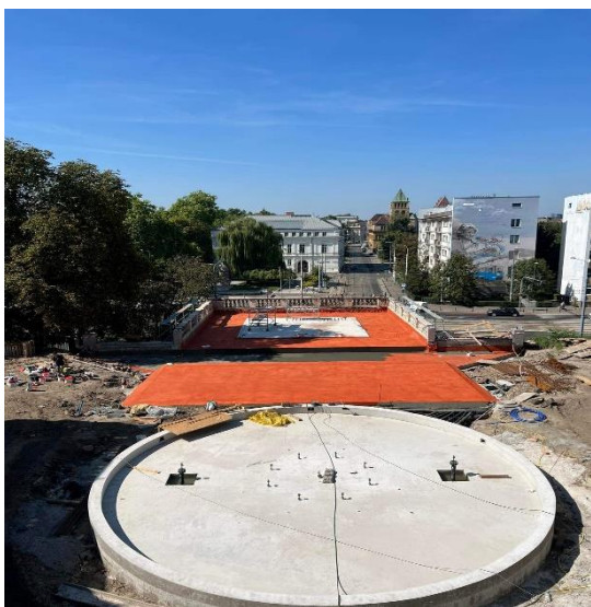
Fotografia 13. Bastion Sakwowy w trakcie przebudowy
