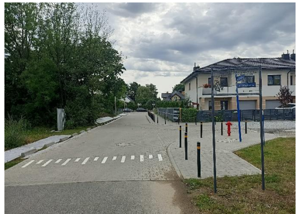
Fotografia 6. Ulica Dobrzykowicka po realizacji inwestycji
