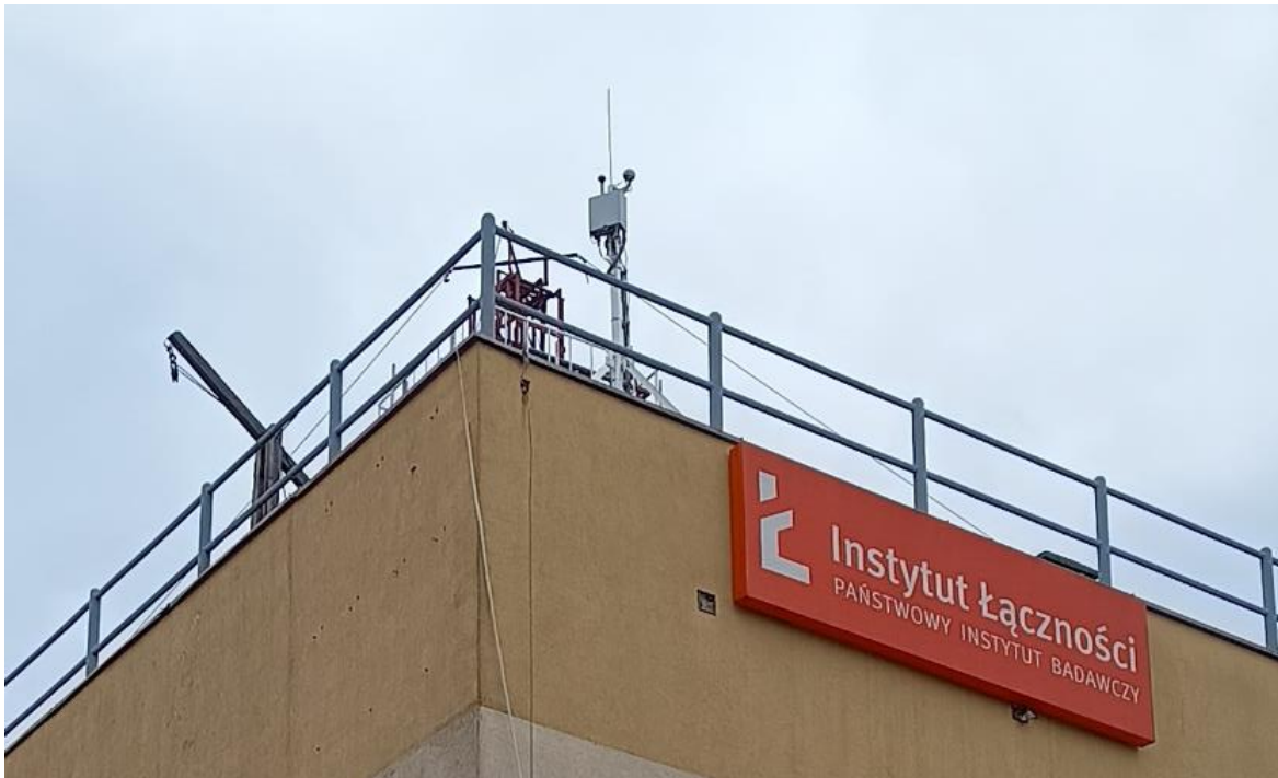
Zdj. 1. Fotografia badanej stacji bazowej IL-PIB WRO 5G TEST
