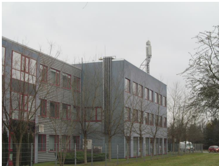
Zał. nr 1: Widok ogólny instalacji radiokomunikacyjnej.
