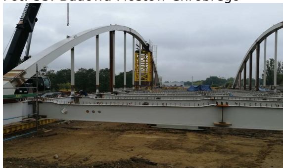
Fot. 53. Budowa Mostów Chrobrego
