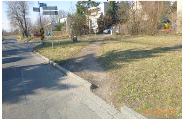
Fot. 25. ul. Mianowskiego – przed remontem
