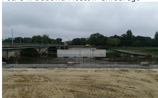
Fot. 54. Budowa Mostów Chrobrego
