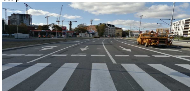
Fot. 50. Trasa tramwajowa wzdłuż ul. Popowickiej-Starogroblowej-Długiej - etap IB i II
