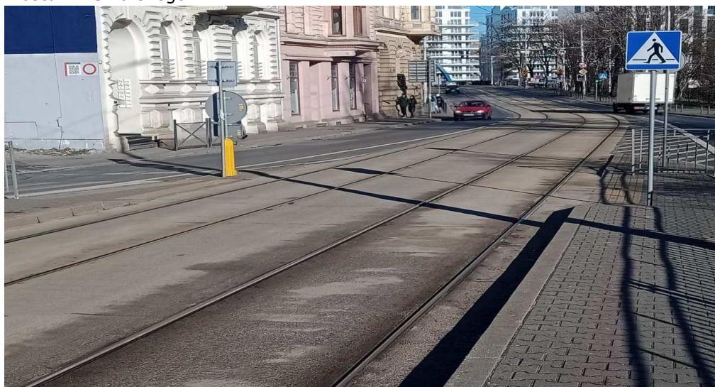
Fot. 73. Nowe torowisko na ul. Podwale, od pl. Jana Pawła II do ul. Księcia Witolda z wyłączeniem mostu W. Sikorskiego
