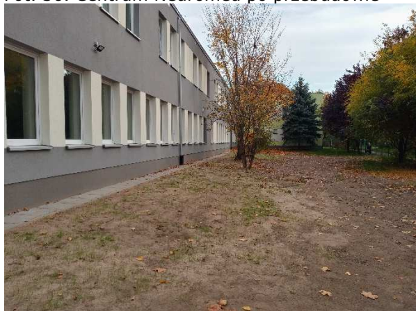
Fot. 36. Centrum Neuromed po przebudowie
