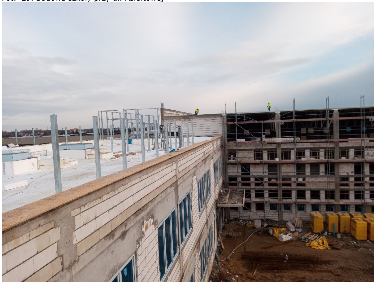
Fot. 29. Budowa szkoły przy ul. Asfaltowej
