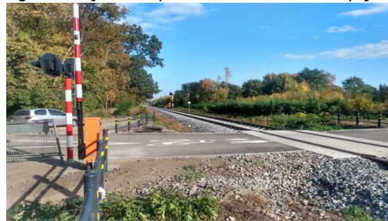
Fot. 56. Przejście pieszo-rowerowe przez linię kolejową nr 285, na skrzyżowaniu z ul. Agrestową – stan po zakończeniu inwestycji
