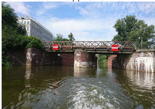
Fot. 61. Most Św. Klary przed remontem
