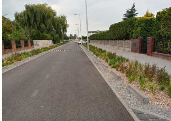
Fot. 7. ul. Marii Wittek - po realizacji inwestycji
