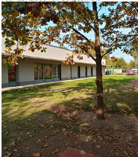
Fot. 23. Żłobek ul. Sołtysowicka
