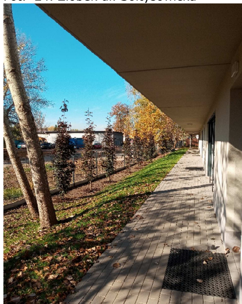
Fot. 24. Żłobek ul. Sołtysowicka
