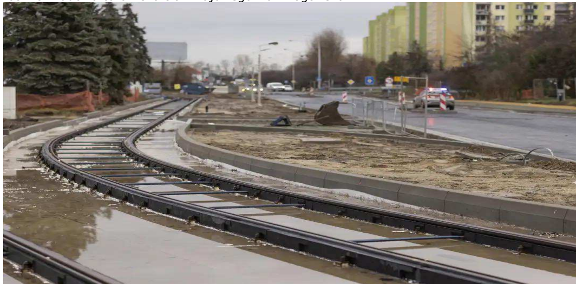
Fot. 48. Budowa torowiska tramwajowego - ul. Rogowska
