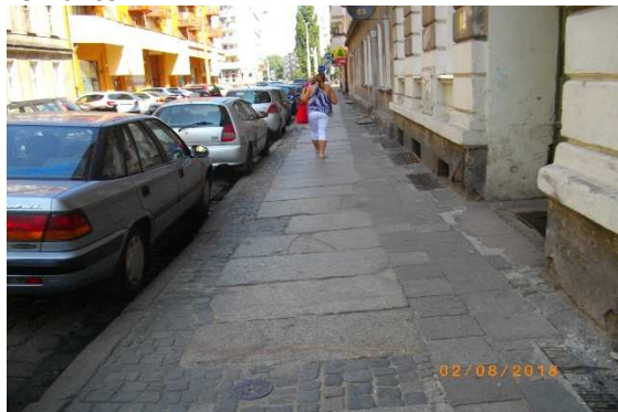
Fot. 27. ul. Sępa-Szarzyńskiego - przed remontem
