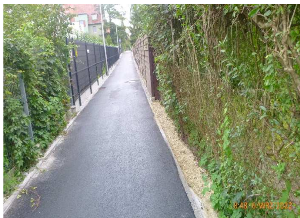
Fot. 6. ul. O. Boznańskiej po remoncie
