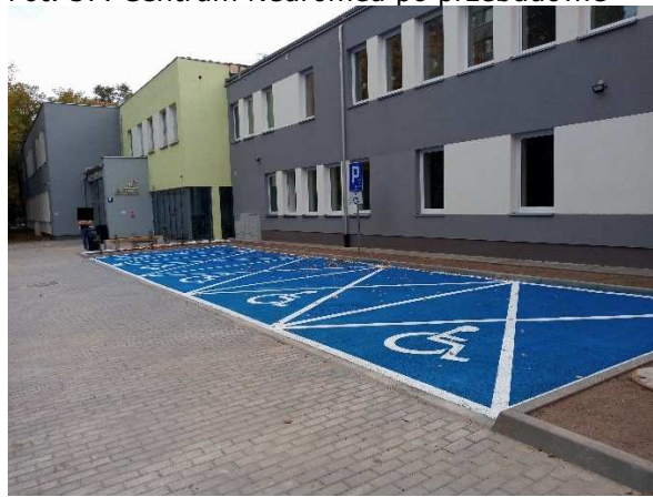
Fot. 37. Centrum Neuromed po przebudowie
