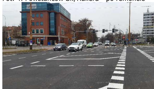
Fot. 4. Powstańców Śl./Hallera - po remoncie
