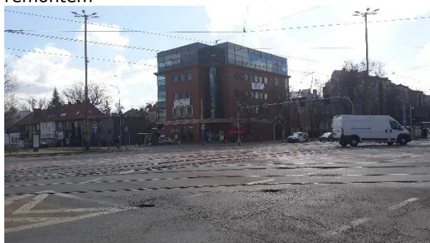
Fot. 3. Powstańców Śl./Hallera - przed remontem
