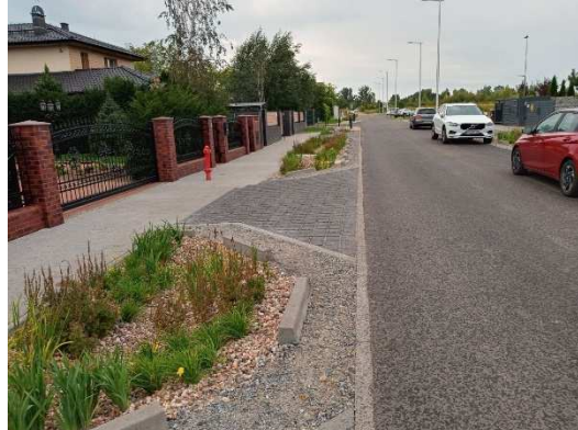
Fot. 8. ul. Marii Wittek - po realizacji inwestycji
