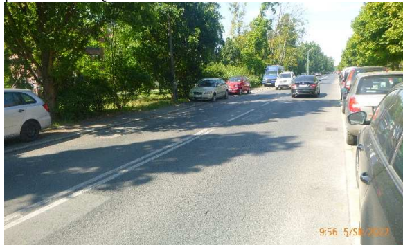
Fot. 9. ul. E. Dembowskiego przed przebudową
