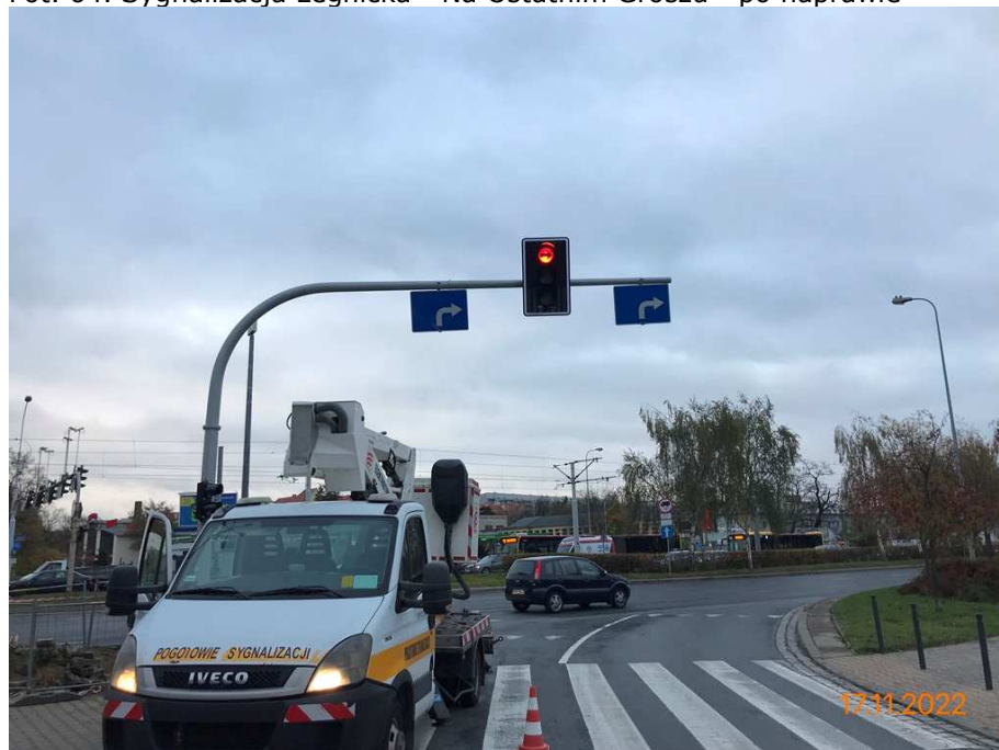
Fot. 64. Sygnalizacja Legnicka - Na Ostatnim Groszu - po naprawie
