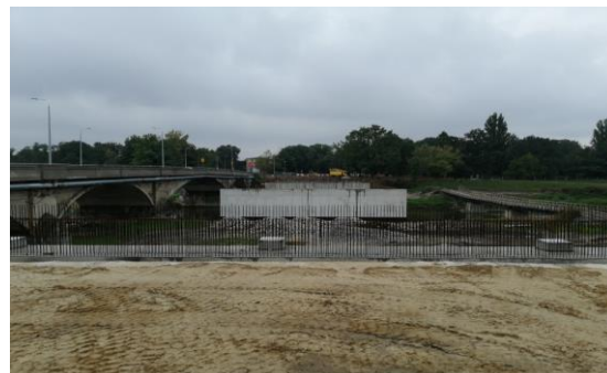
Fot. 54. Budowa Mostów Chrobrego
