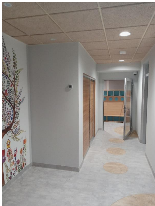
Fot. 31. Przedszkole przy ul. Zaporoskiej - po remoncie
