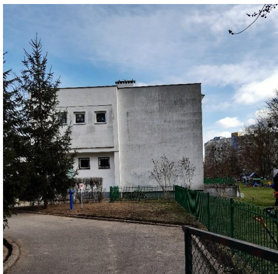
Fot. 17. Żłobek ul. Dokerska - przed
