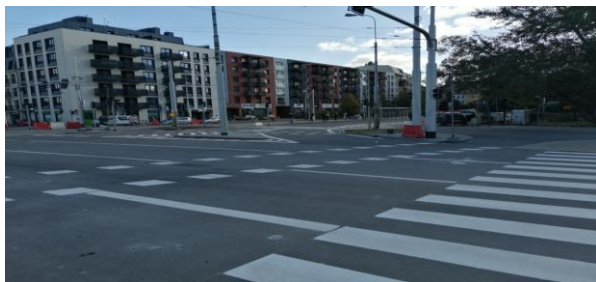
Fot. 49. Trasa tramwajowa wzdłuż ul. Popowickiej-Starogroblowej-Długiej - etap IB i II
