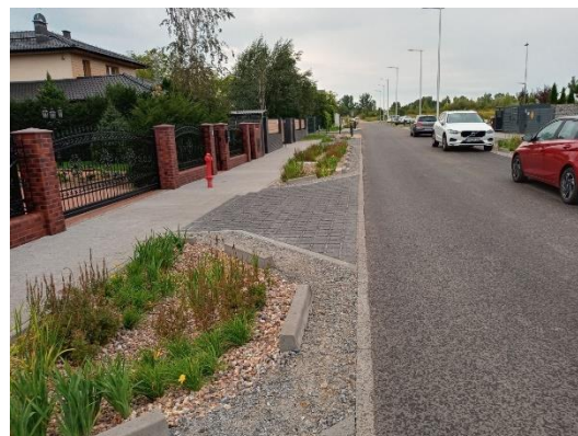
Fot. 8. ul. Marii Wittek - po realizacji inwestycji
