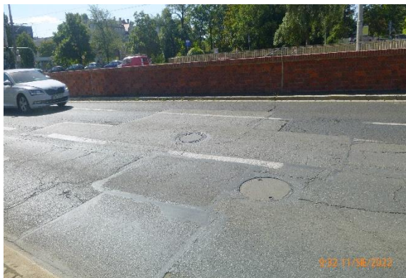
Fot. 59. ul. Oławska - przed remontem
