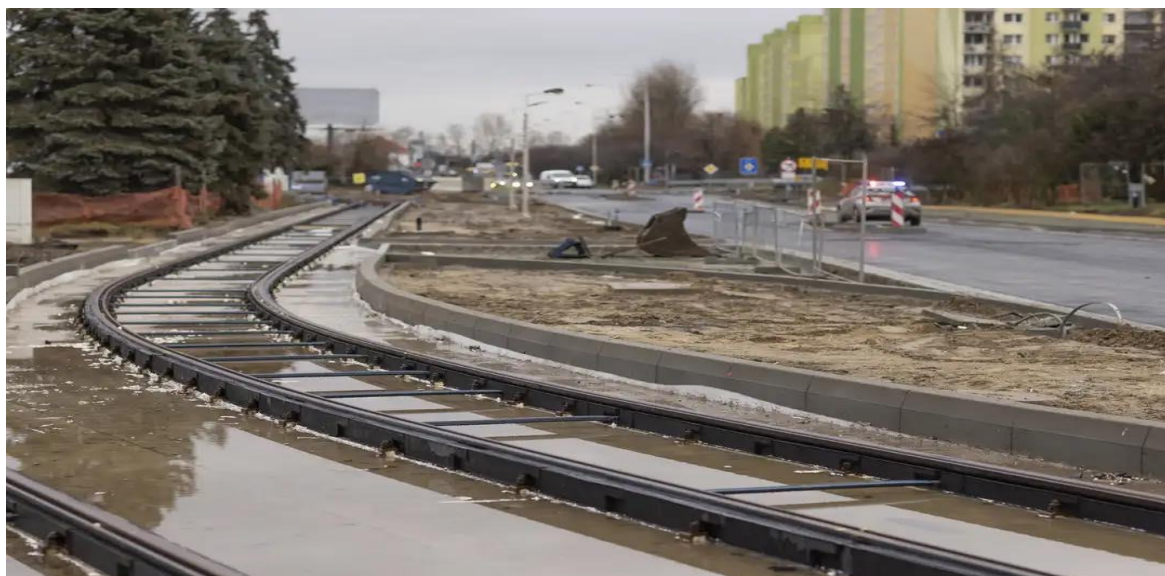
Fot. 48. Budowa torowiska tramwajowego - ul. Rogowska
