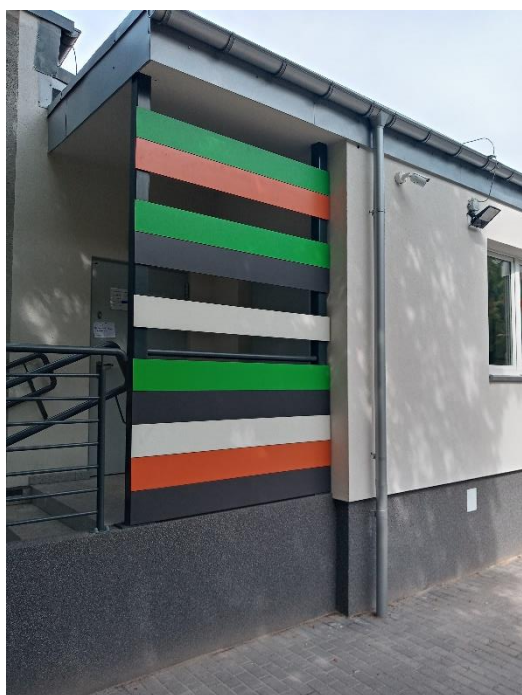
Fot. 30. Przedszkole przy ul. Zaporoskiej - po remoncie
