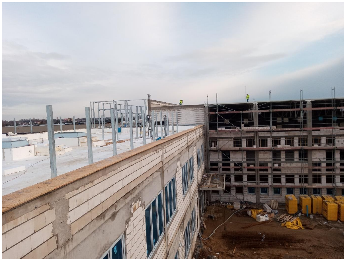
Fot. 29. Budowa szkoły przy ul. Asfaltowej
