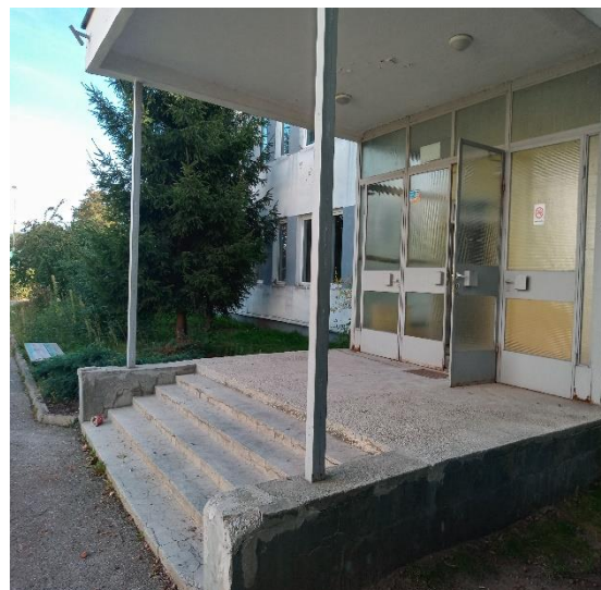
Fot. 18. Żłobek ul. Dokerska - przed
