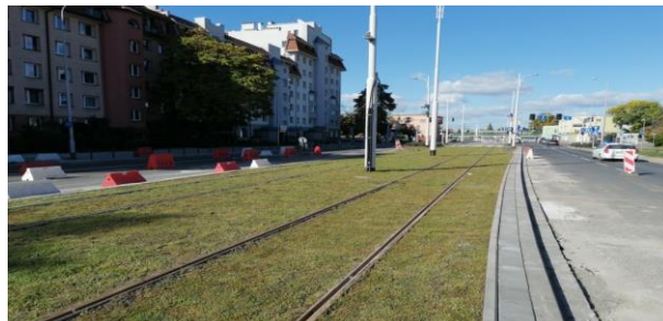
Fot. 52. Trasa tramwajowa wzdłuż ul. Popowickiej-Starogroblowej-Długiej - etap IB i II
