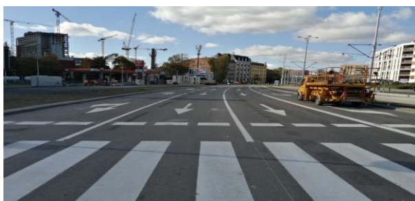
Fot. 50. Trasa tramwajowa wzdłuż ul. Popowickiej-Starogroblowej-Długiej - etap IB i II
