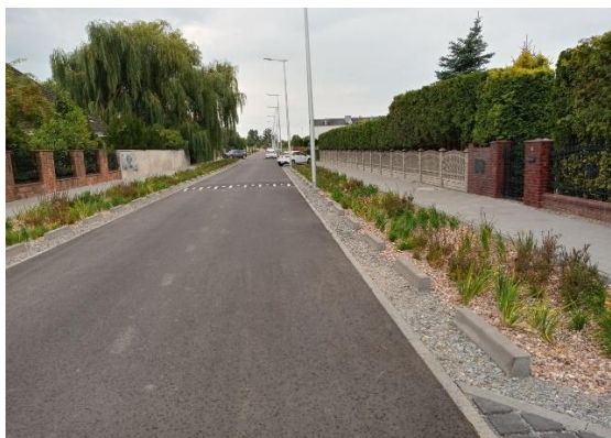
Fot. 7. ul. Marii Wittek - po realizacji inwestycji
