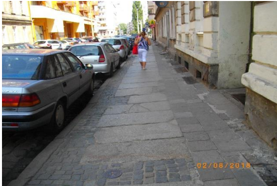
Fot. 27. ul. Sępa-Szarzyńskiego - przed remontem
