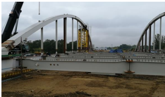
Fot. 53. Budowa Mostów Chrobrego
