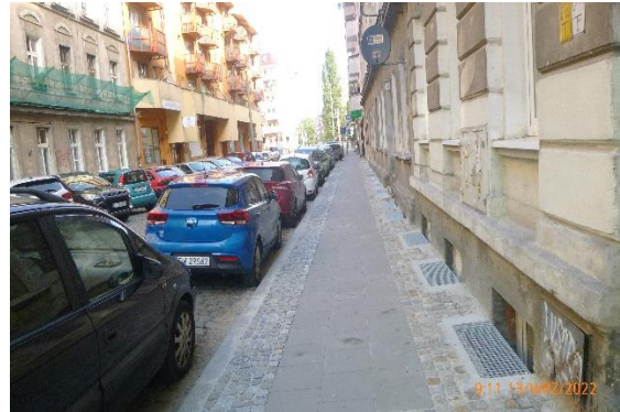
Fot. 28. ul. Sępa-Szarzyńskiego - po remoncie
