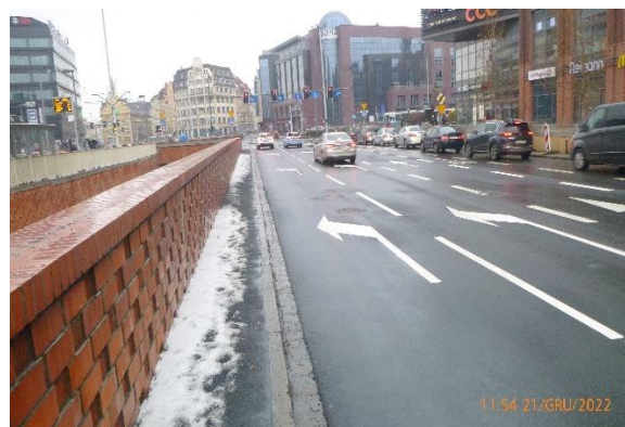
Fot. 60. ul. Oławska - po remoncie
