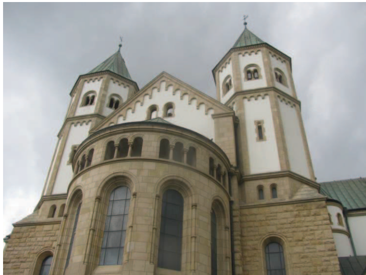
Zał. nr 1: Widok ogólny instalacji radiokomunikacyjnej.
