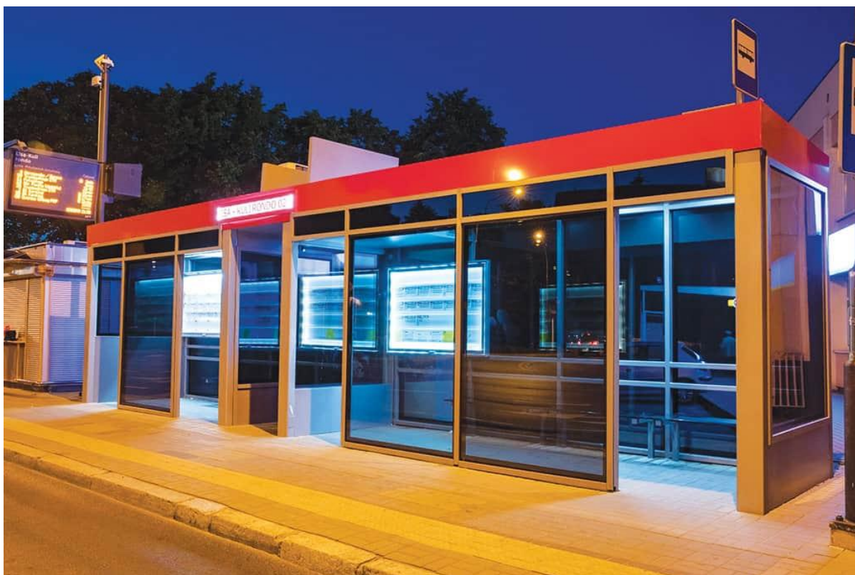
Zdjęcie 74 Solarna wiata przystankowa w Rzeszowie
