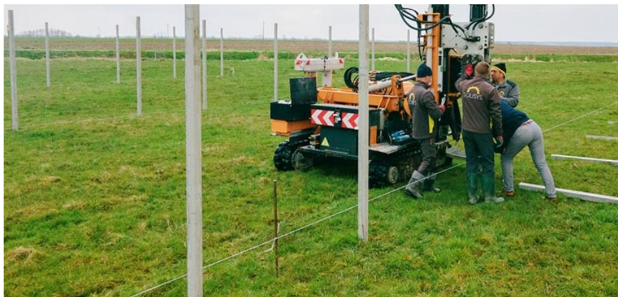
Zdjęcie 78 Stawianie konstrukcji wsporczej ze strunobetonu pod farmę fotowoltaiczną
