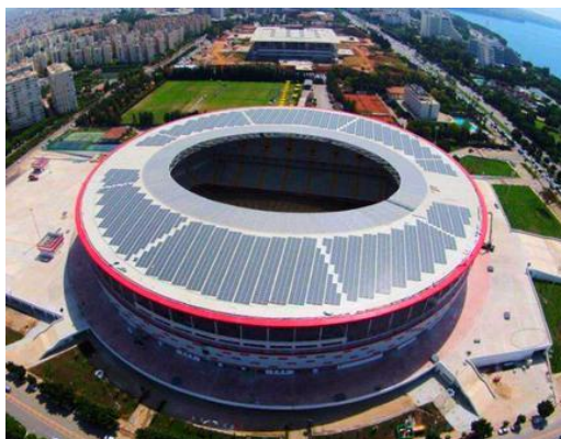
Zdjęcie 1 Instalacja PV o mocy 1,4 MWp na Antalya Arena w Turcji
