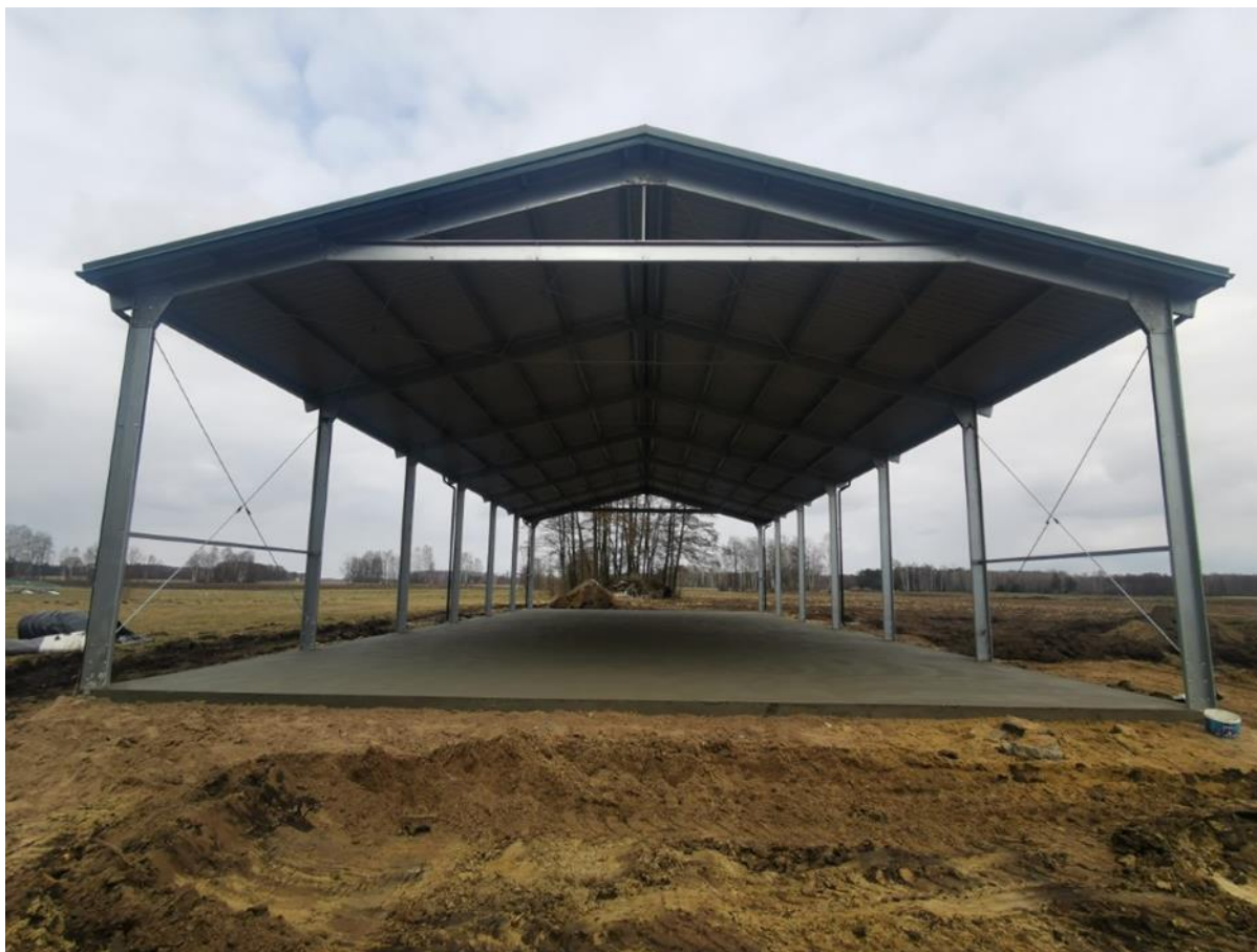
Zdjęcie 80 Przykładowa konstrukcja wiaty stalowej
