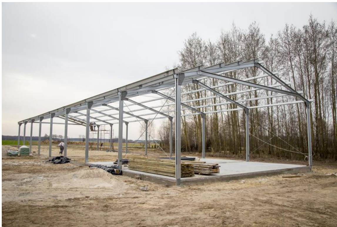
Zdjęcie 79 Przykładowa konstrukcja wiaty stalowej
