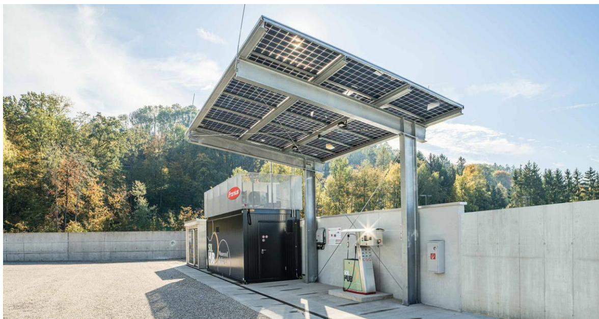
Zdjęcie 26 Rozwiązanie łączące produkcję energii elektrycznej z instalacji fotowoltaicznej przeznaczonej do produkcji wodoru w elektrolizerze oraz tankowania wodoru
