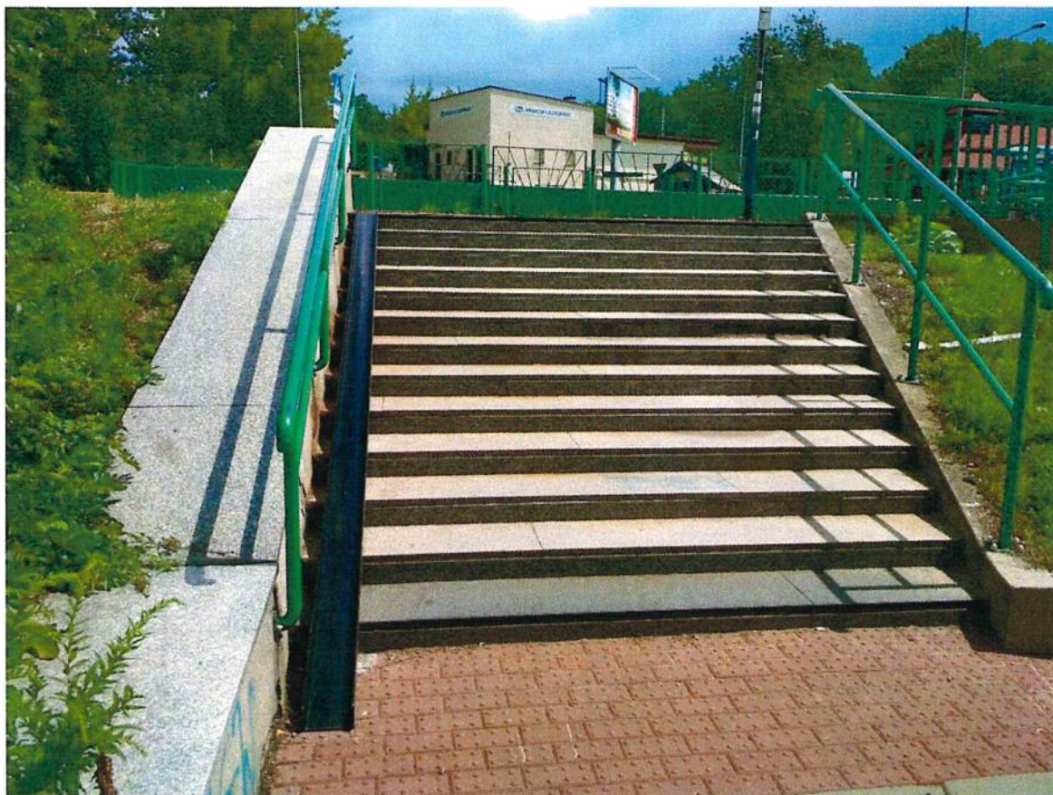
Rysunek 3 Przykładowa prowadnica zainstalowana w Krakowie
