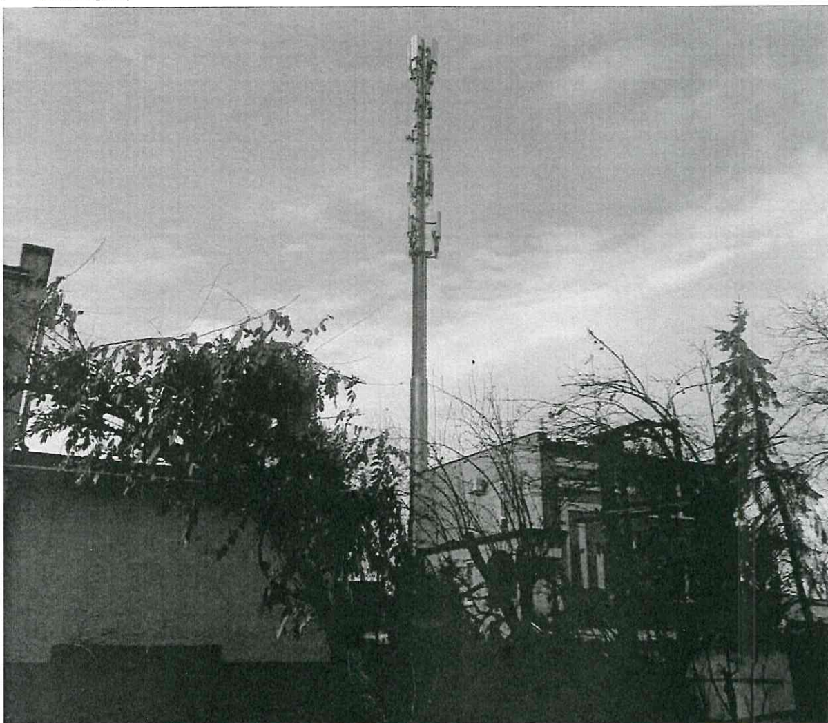
Zdjęcie 1 Badany obiekt
