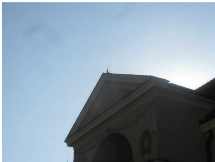
Zał. nr 1: Widok ogólny instalacji radiokomunikacyjnej.
