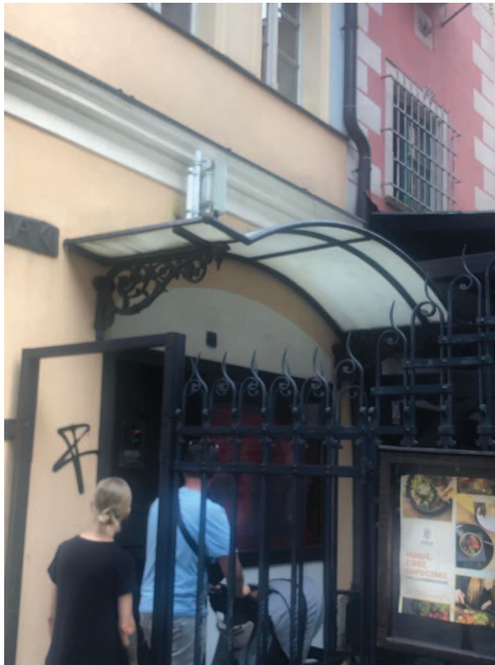
Zał. nr 1: Widok ogólny instalacji radiokomunikacyjnej.
