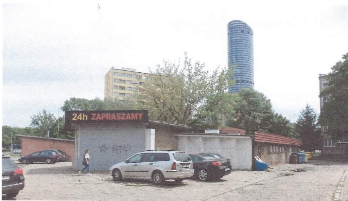
Fot. 10 – 11. Budynek nr 1- część przeznaczona na sklep spożywczy. Budynek przewidziany do wyburzenia
