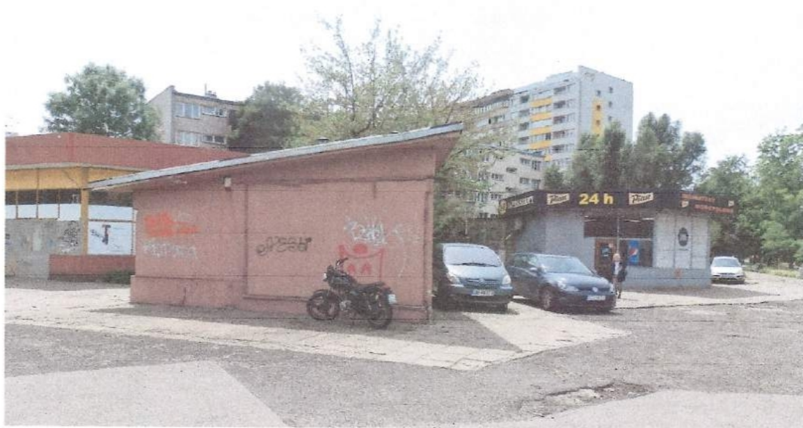
Fot. 12 – 13. Budynek nr 2- pustostan. Budynek przewidziany do wyburzenia
