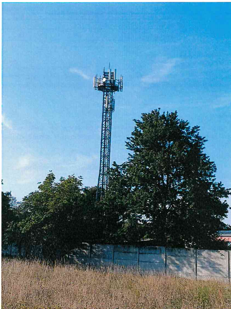
Zdjęcie 1 Badany obiekt
