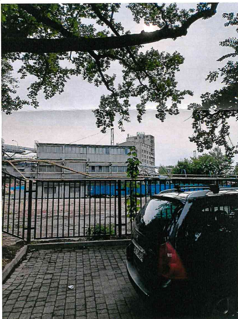
Zdjęcie 1 Badany obiekt
