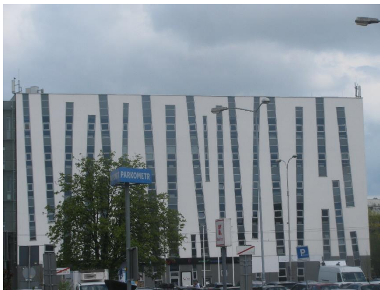
Zał. nr 1: Widok ogólny instalacji radiokomunikacyjnej.
