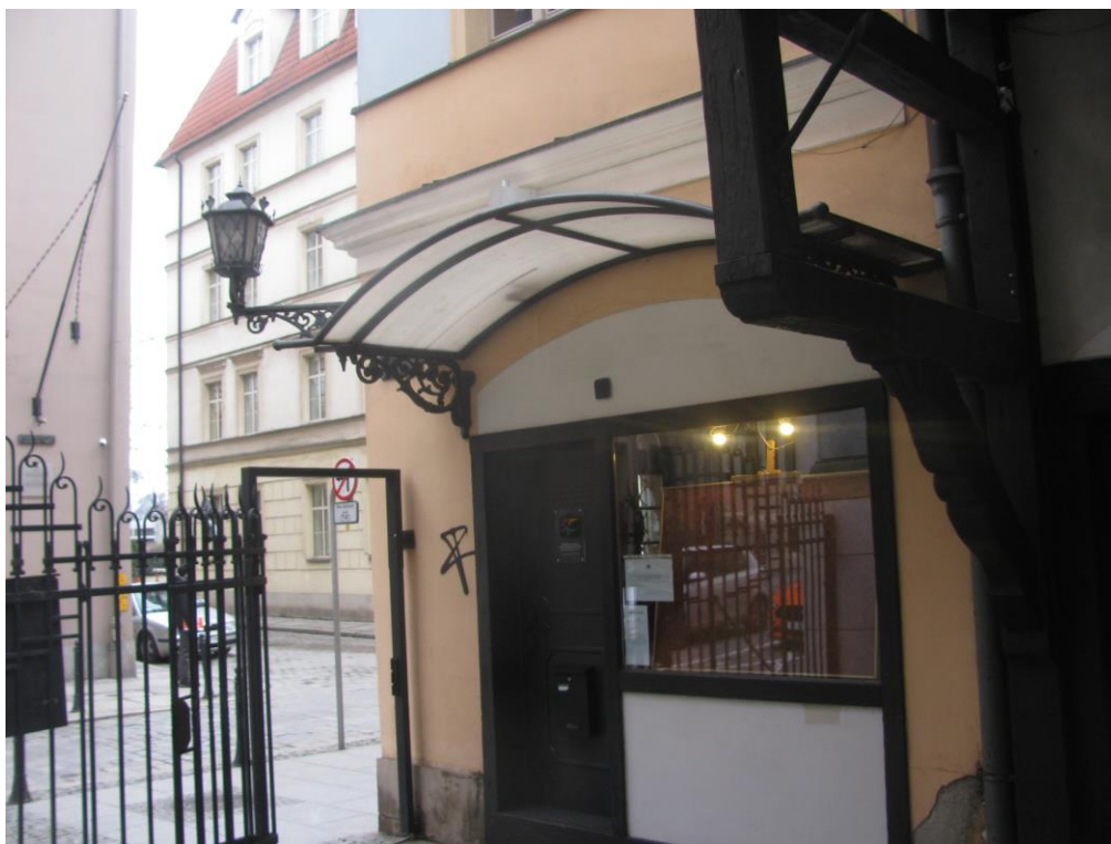
Zał. nr 1: Widok ogólny instalacji radiokomunikacyjnej.
