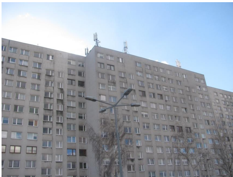
Zał. nr 1: Widok ogólny instalacji radiokomunikacyjnej.
