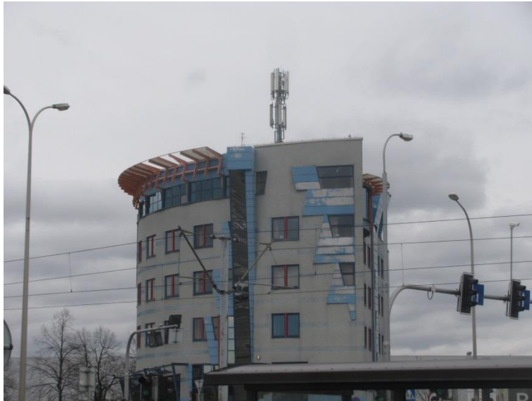
Zał. nr 1: Widok ogólny instalacji radiokomunikacyjnej.
