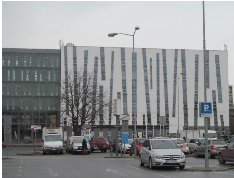
Załącznik nr 1: Widok ogólny instalacji radiokomunikacyjnej.
